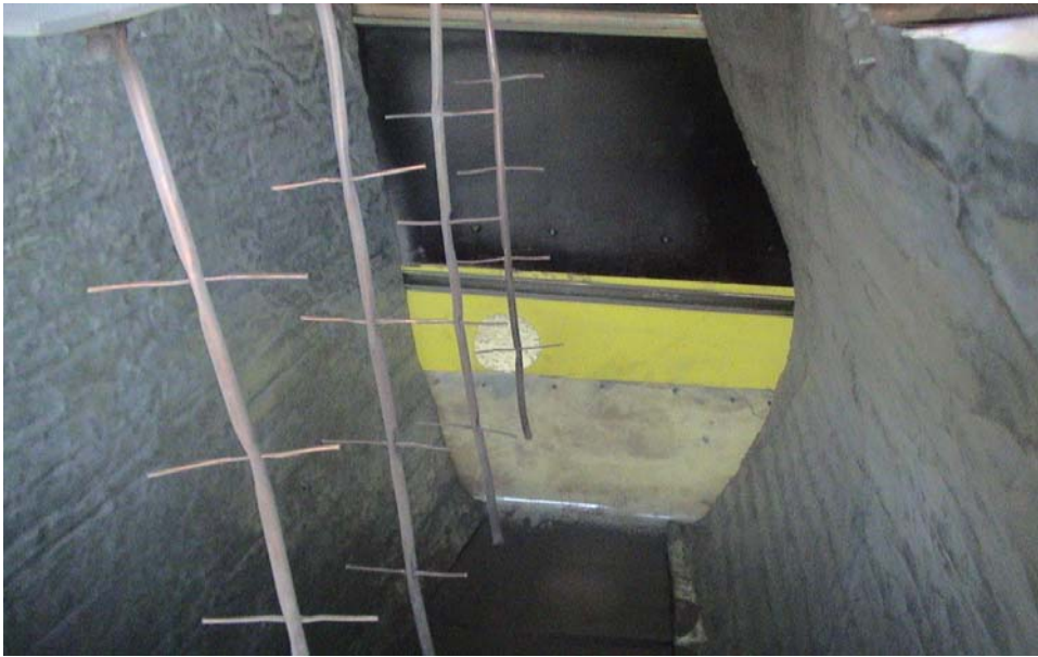
Şekil 5.6. Dikenli boru tipi yükleme elektrodu
