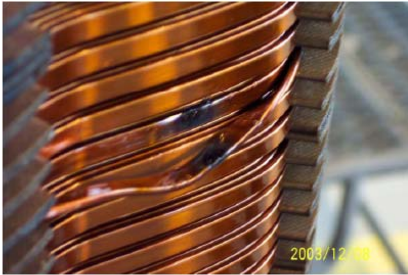
Resim 6.5. Transformator bobininde yaşanan sipir kısa devresi [50]
