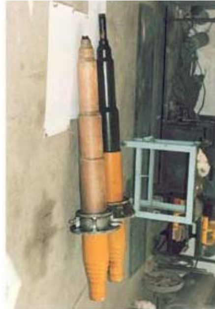
Resim 3.4. A ve B fazı bushing çekirdekleri
