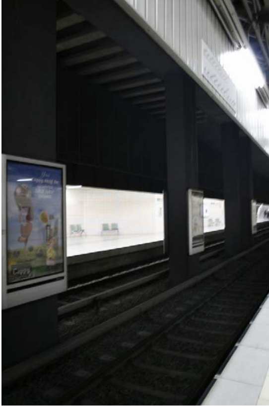
Resim 3.4. Ankaray Maltepe İstasyonu yolcu platformundan istasyon içi görünüm
