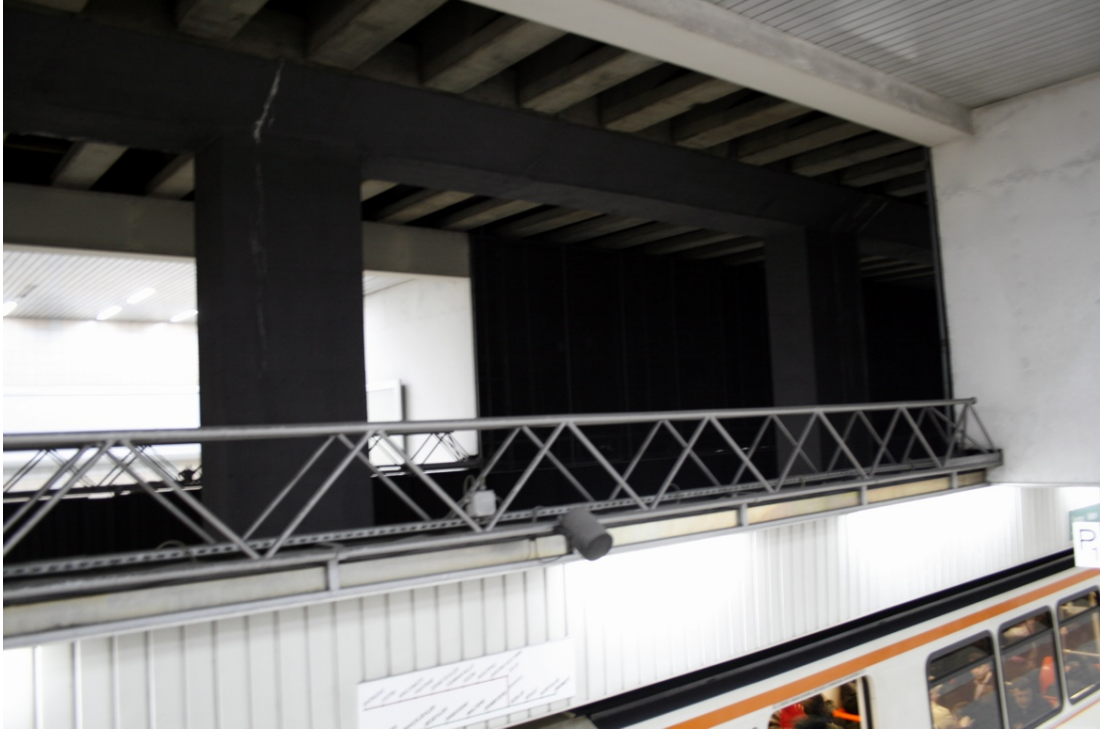
Resim 3.2. Ankaray Maltepe İstasyonu Denizcilik Müsteşarlığı tarafındaki platform merdivenlerinin başından platform üstü görünüş
