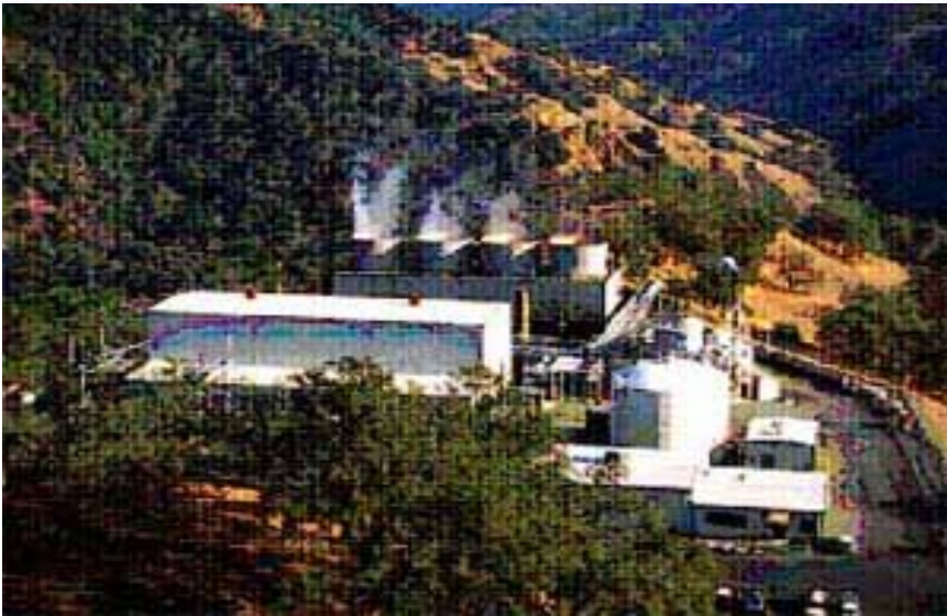
Resim 3.4. Jeotermal enerjiden elektrik enerjisi üretim santrali [14].
