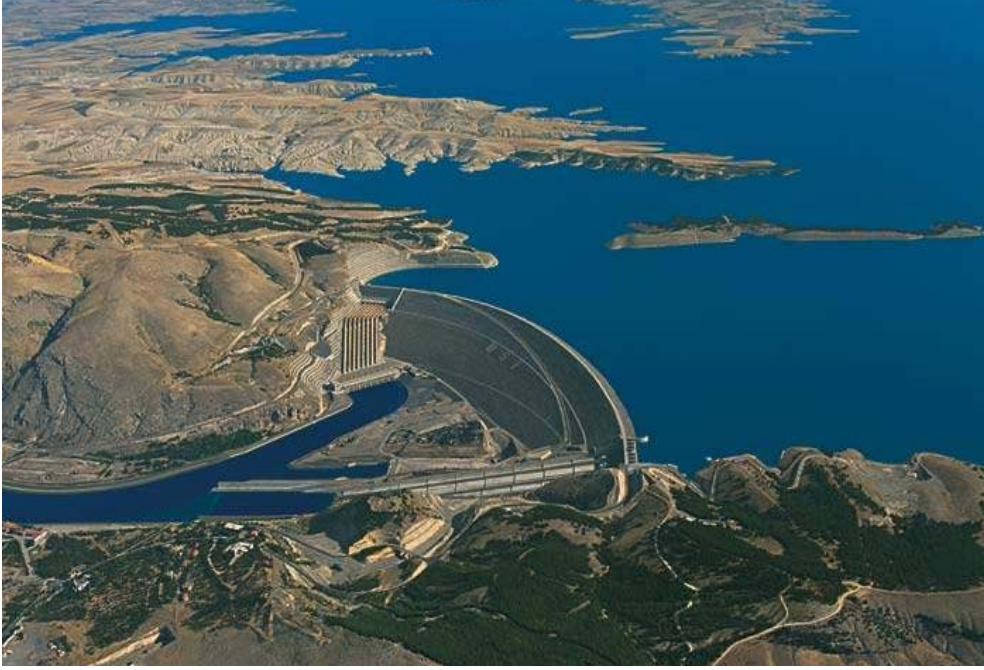
Resim 3.3. Atatürk barajı hidroelektrik santrali
