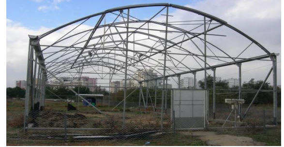
Şekil 1.25. Alüminyum konstrüksiyonlu seralar (Anonim 2011a)
