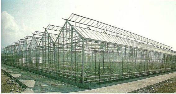
Şekil 1.24 Çelik konstrüksiyonlu seralar (Titiz 2004)
