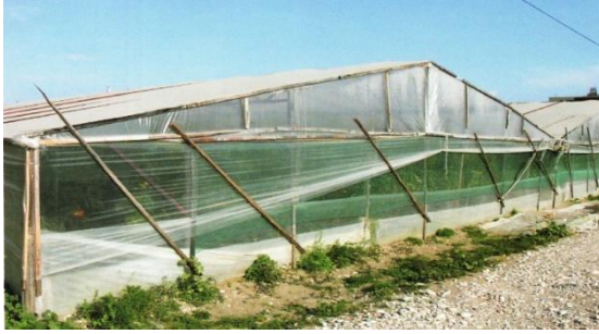
Şekil 1.23. Ahşap konstrüksiyonlu seralar (Titiz 2004)
