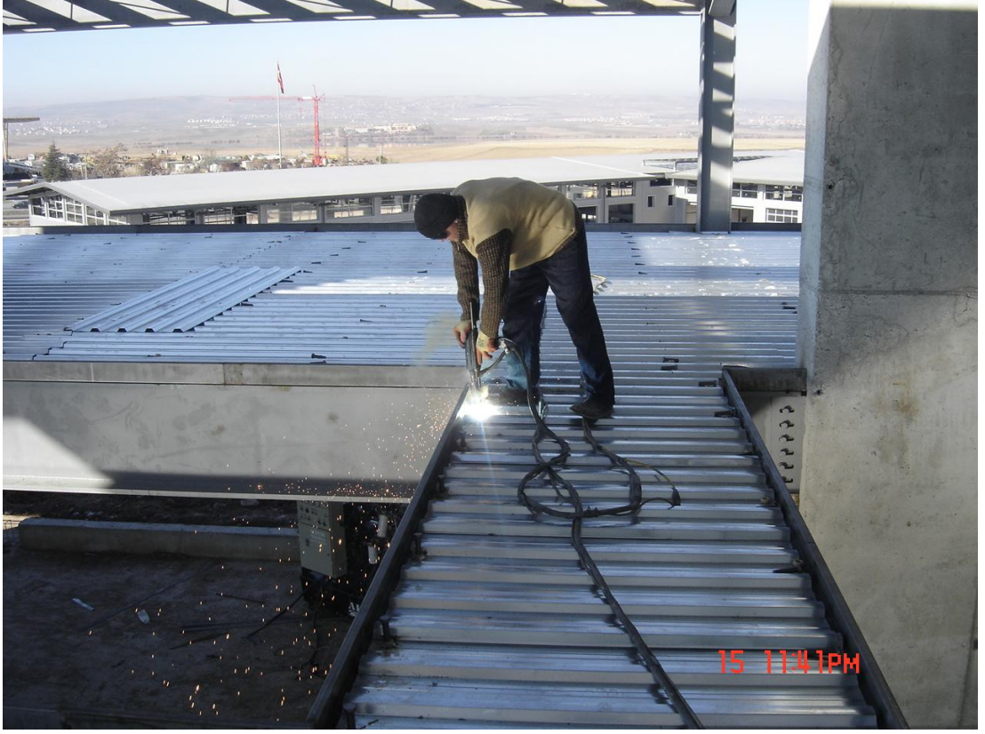
Resim 2.1. Kayma çivisinin kaynaklanması
