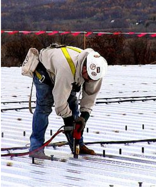
Resim 2.2. Kayma çivisinin kaynaklanması
