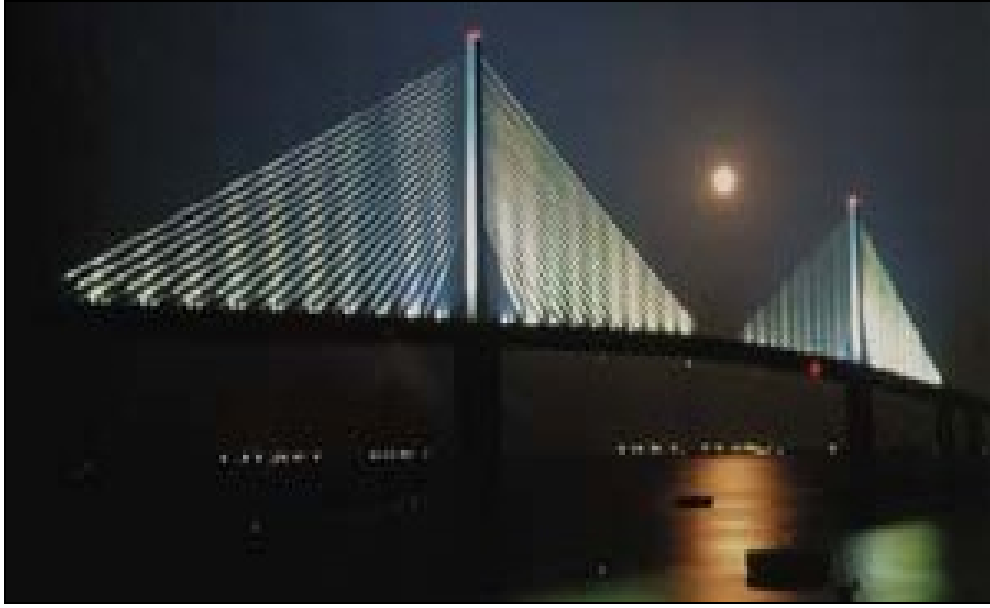
Resim 1.3. Sunshine Skyway Köprüsü (ABD)
