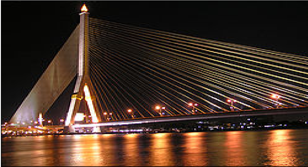
Resim 1.6 Rama VIII Köprüsü (Thailand)
