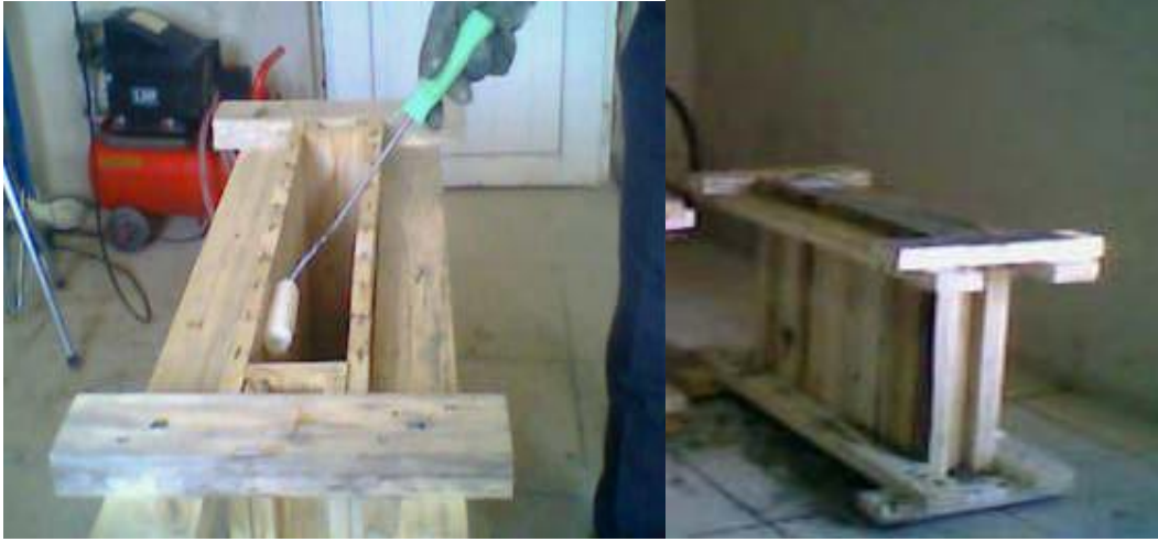
Resim 3.2. Kalıp yağı uygulaması ve beton
