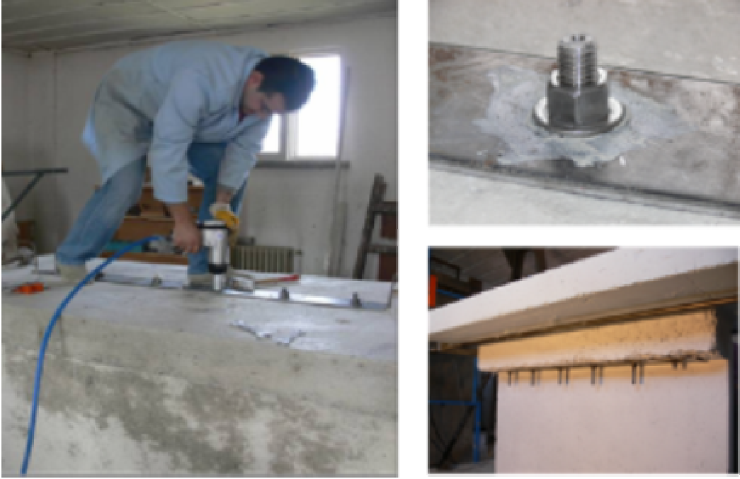
Resim 4.2. Birleşimde kullanılan bağlantı çubuklarının havalı tabanca ile sıkıştırılması
