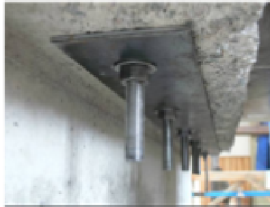
Resim 4.1. Bağlantı çubuklarının açılan deliklere epoksi ile yerleştirilmesi
