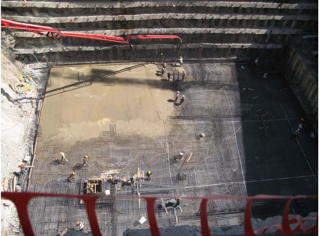
Resim 4.19. C- Blok -8. bodrum temel betonu dökümü, [Turgut, 2007]
