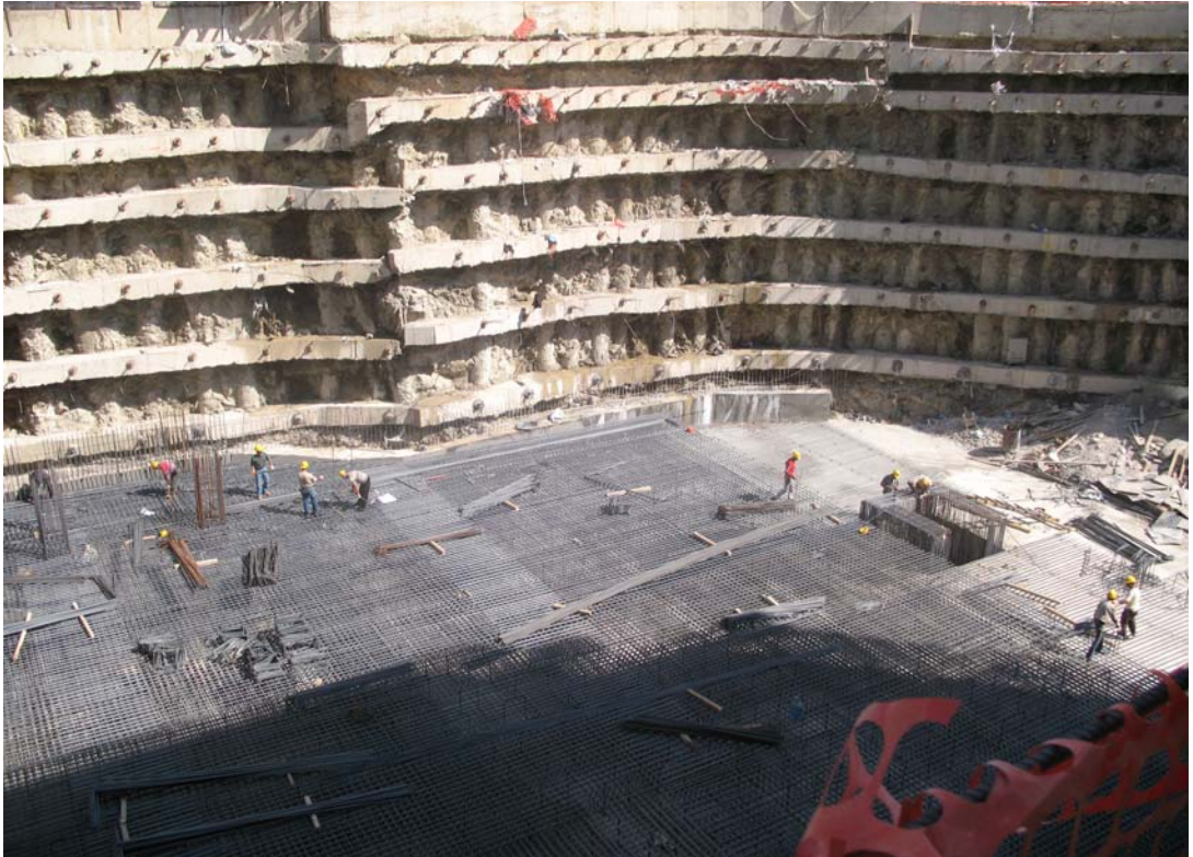
Resim 4.13. Fore kazık uygulaması ile açılan otopark yapısına ait temel çukuru, [Turgut, 2007]
