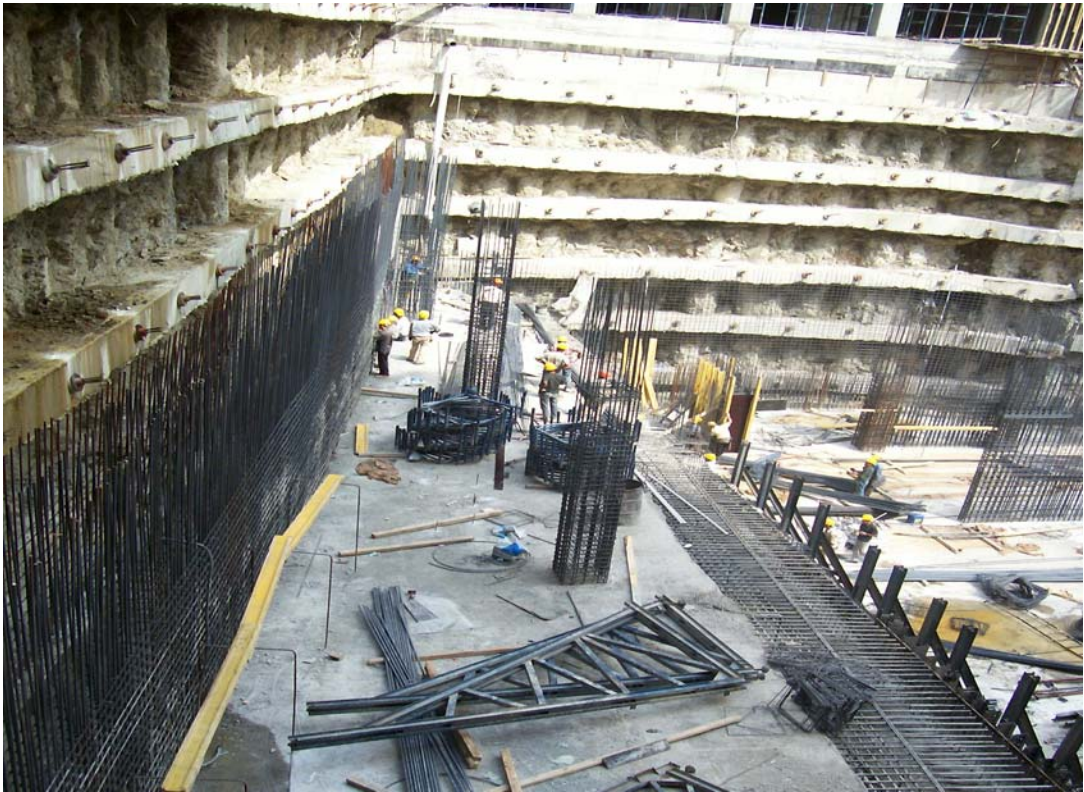
Resim 4.22. C- Blok -25.00 kotu bodrum perde filizleri, [Turgut, 2007]
