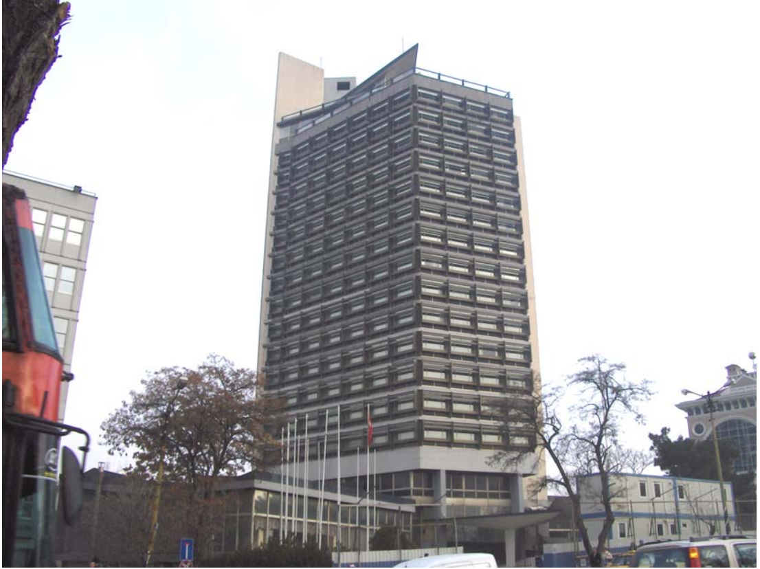
Resim 3.11. Orijinal siyah suni taş yerine takılan alüminyum güneş kırıcıları, [Turgut, 2006]
