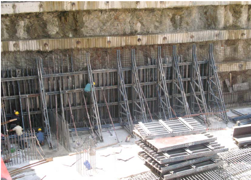
Resim 4.15. Bodrum kat için kalıp hazırlama uygulaması, [Turgut, 2007]
