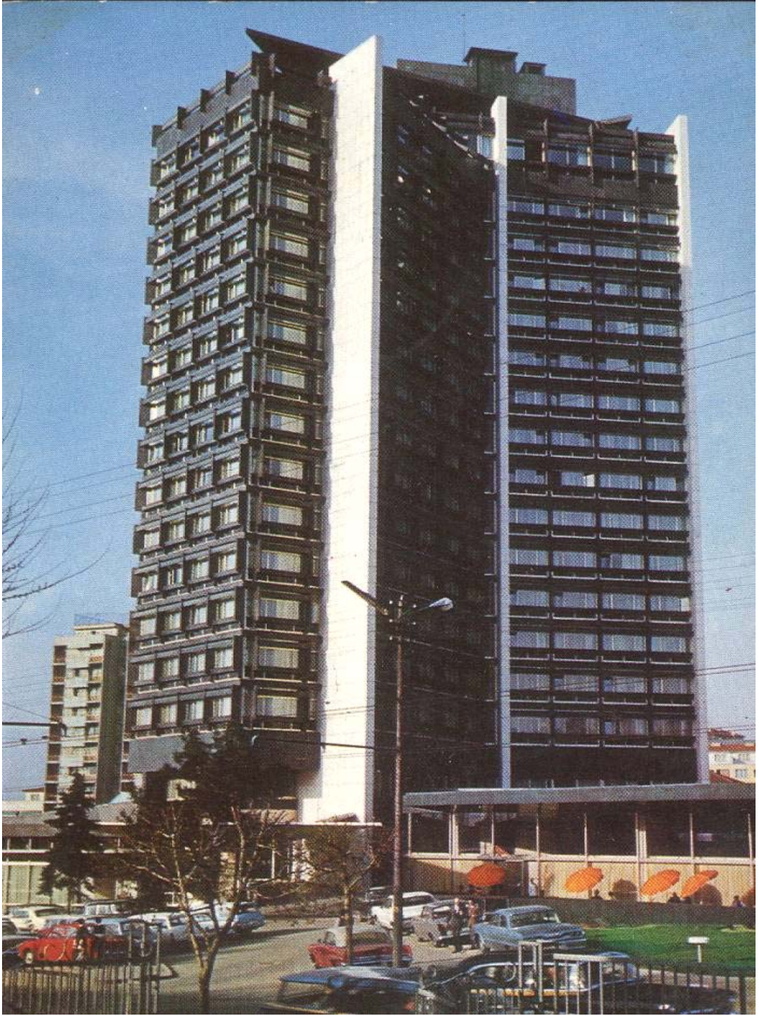
Resim 3.3. Büyük Ankara Oteli'nin 1960'lardaki görüntüsü. Emekli Sandığı tarafından sökülmeden önceki orijinal suni taş güneş kırıcı ilk hali. [Turgut, 2010]
