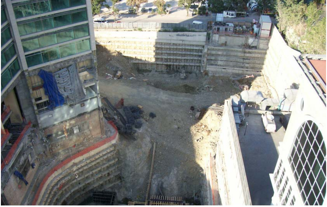
Resim 4.16. Bodrum hafriyatı yapılırken, sağda TV8 Yapısı, [Turgut, 2007]
