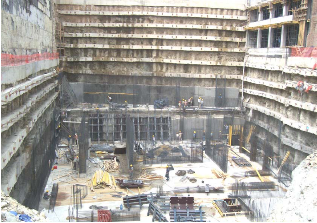
Resim 4.21. C- Blok -8. Bodrum kolon filizleri, [Turgut, 2007]
