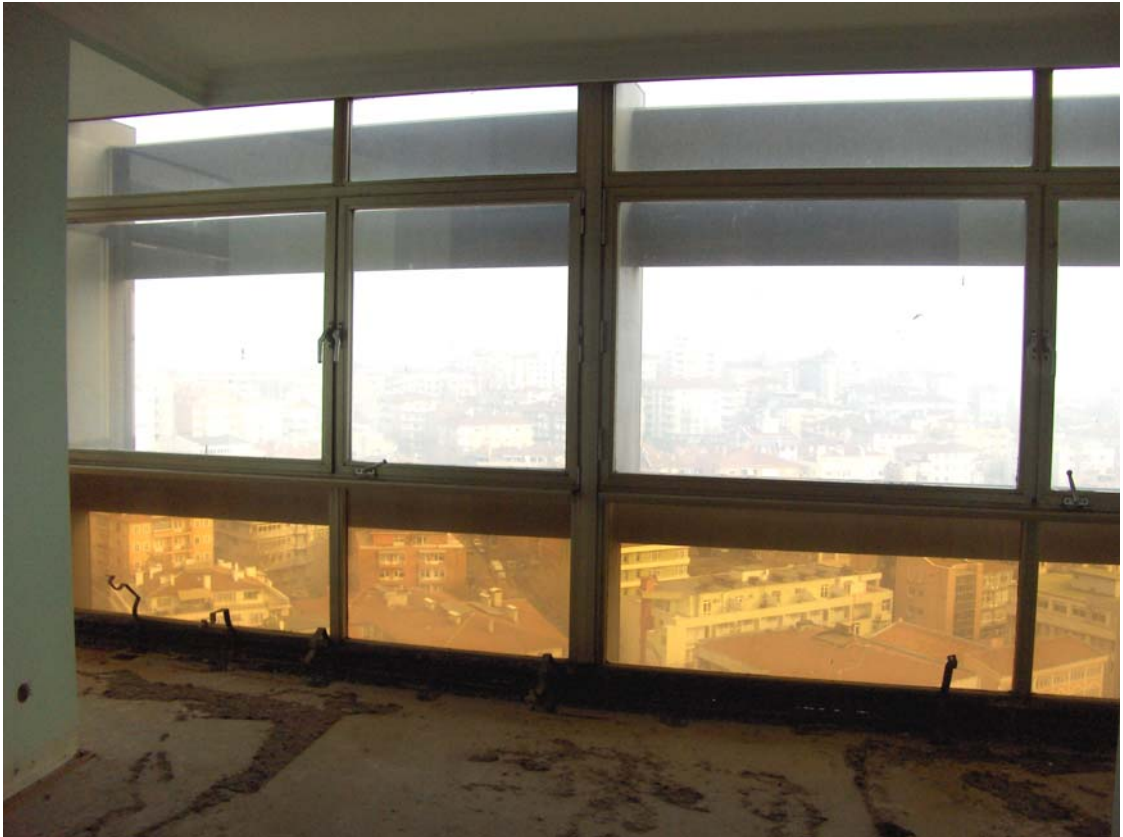
Resim 3.17. Orijinal olmayan alüminyum güneş kırıcıları ve renkli camlar, [Turgut, 2006]
