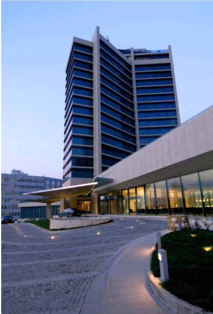
Resim 4.8. Mimar Gökhan Hakan Turgut tarafından tasarlanan cephe ve peyzaj uygulaması, [Çelikler Holding, 2010]
