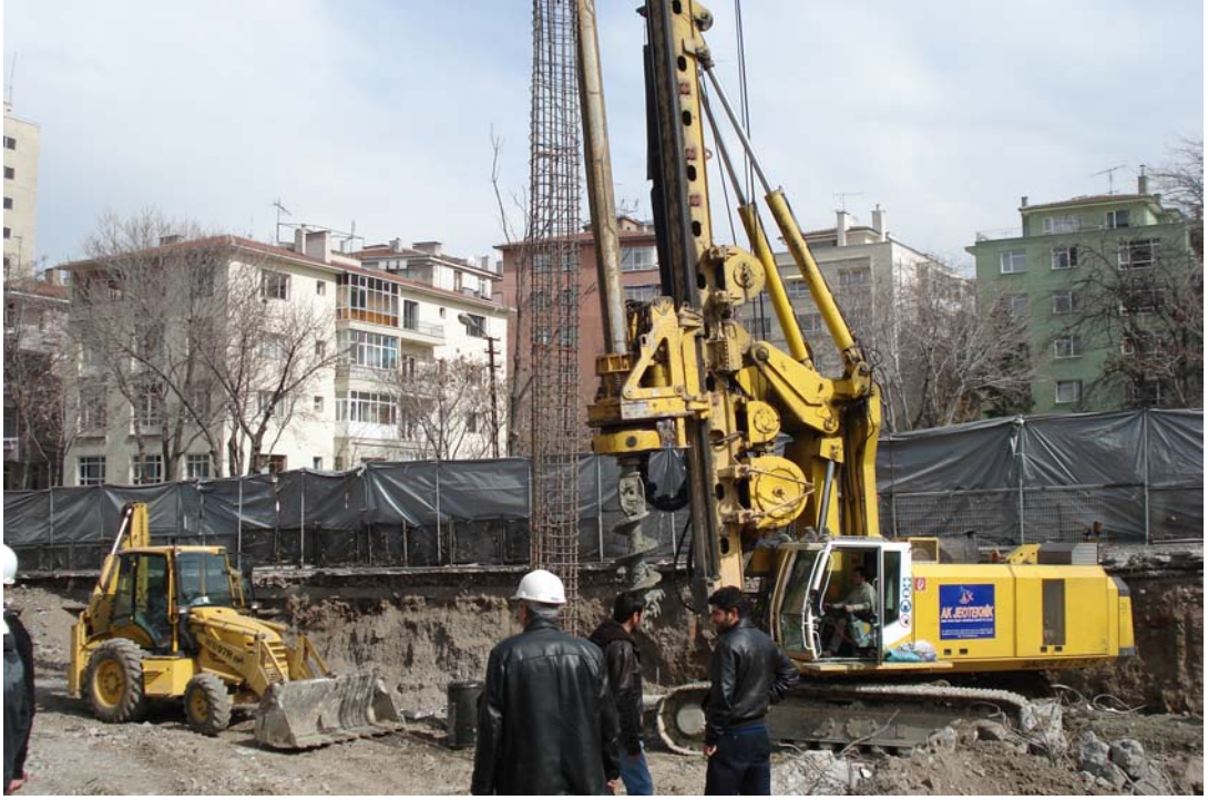
Resim 4.12. Fore kazık delme makinesi, [Turgut, 2007]
