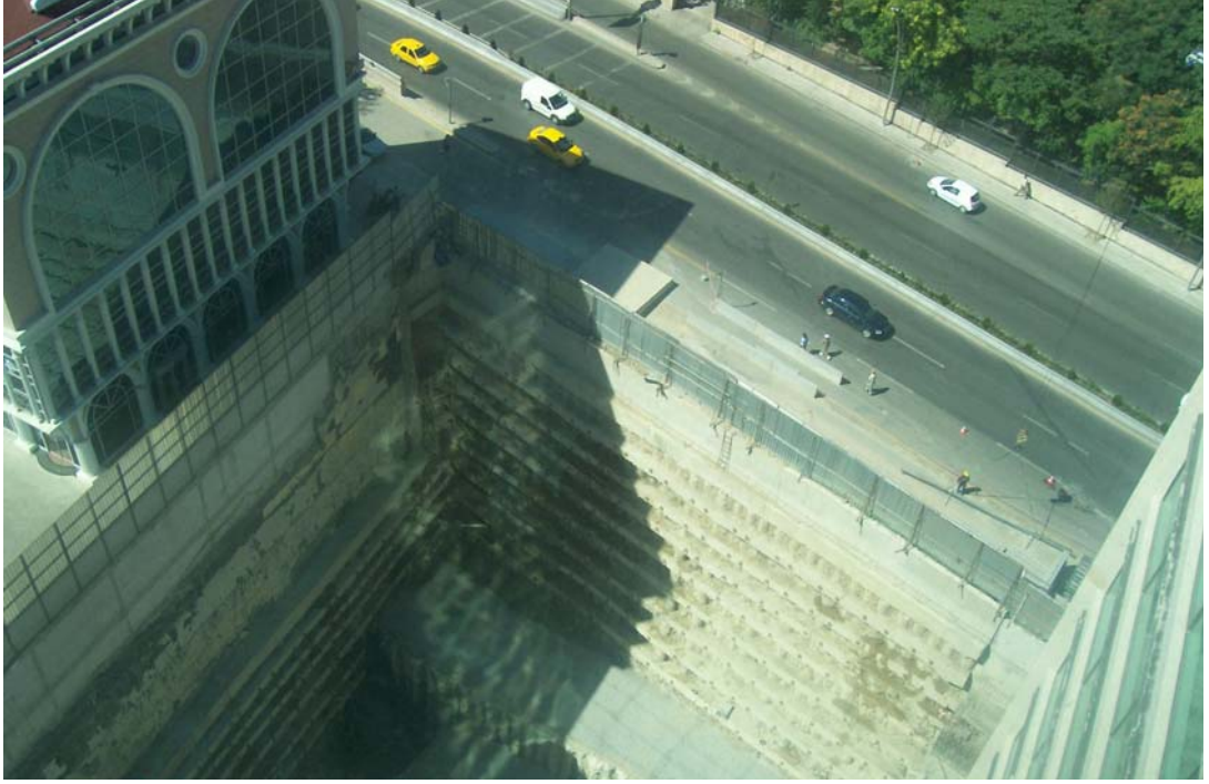
Resim 4.18. -30.00 kotundaki temel çukurunun +55.60 kotundaki üst terastan görünüşü, [Turgut, 2007]
