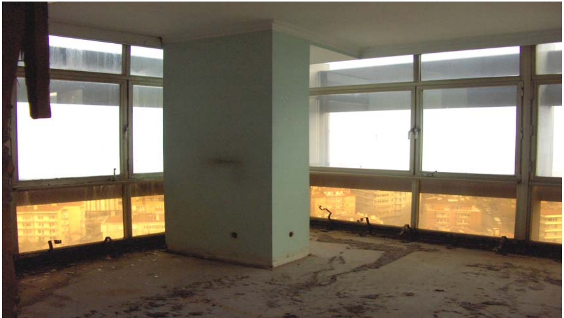
Resim 3.16. Yatak katlarının ve dış cephe doğramalarının 2005 yılındaki durumu, [Turgut, 2005]
