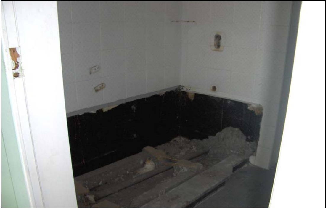
Resim 4.4. 2005 yılında yatak katlarında bir banyo, “sökülmüş küvet ve kapılar”, [Turgut, 2005]
