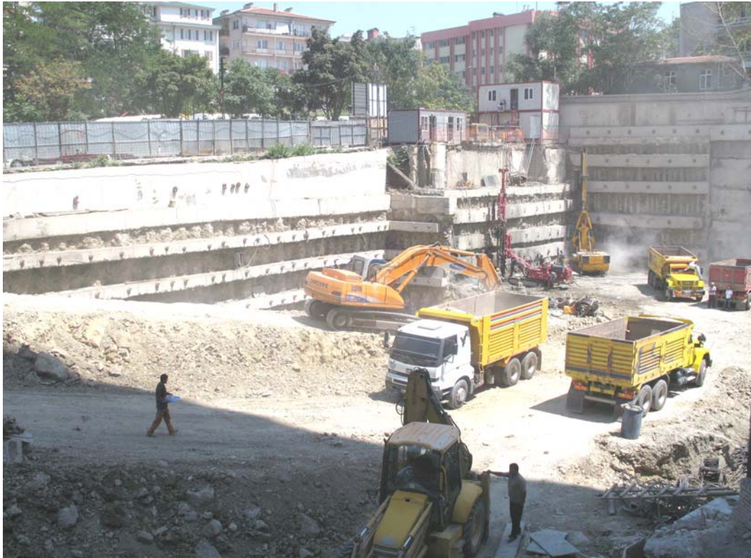
Resim 4.14. Aşamalı yürütülen temel hafriyat çalışmaları, [Turgut, 2007]
