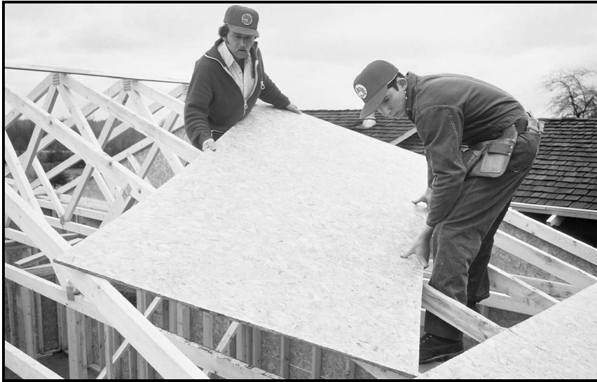
Resim 3.9. 60 cm lik ahşap kafes aralığı ve üst örtü ölçüsel ilişkisi.
