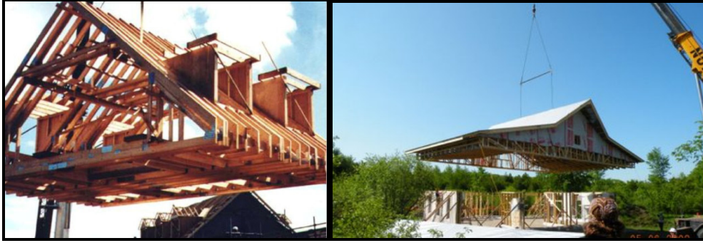
Resim 3.6. Ahşap kafeslerin bir bütün halinde vinçle kurulumu
