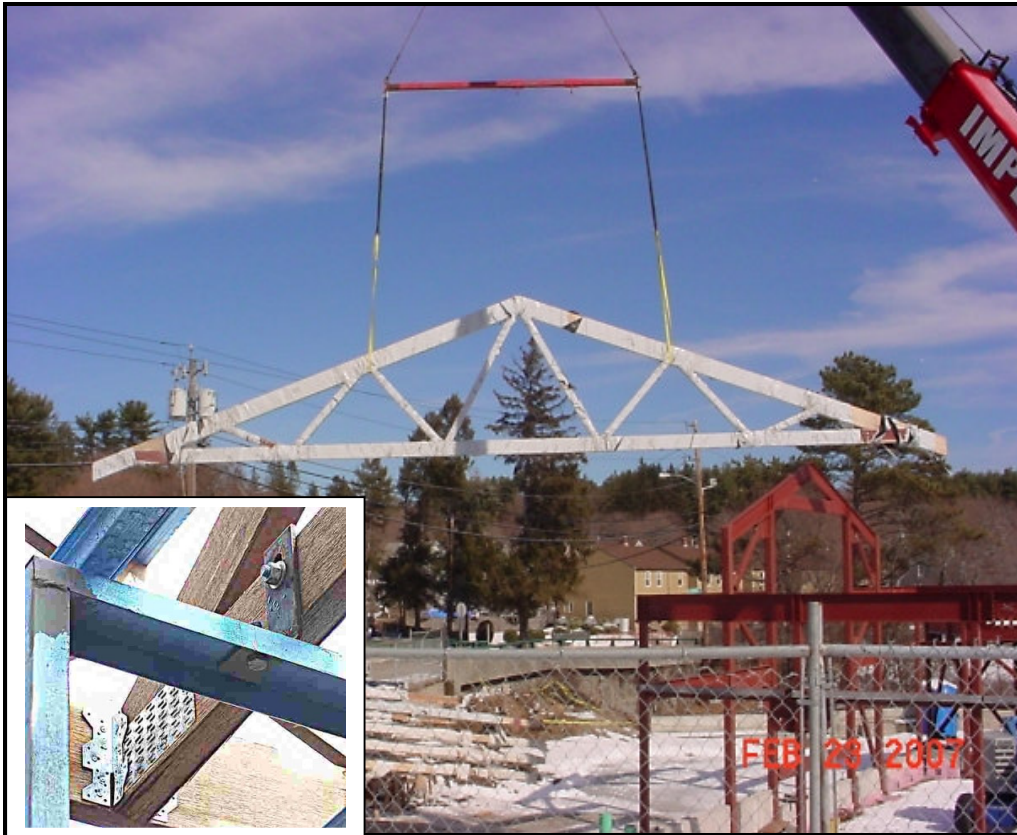
Resim 3.7. Ahşap kafes çatı sisteminin çelik yapıda kullanılması
