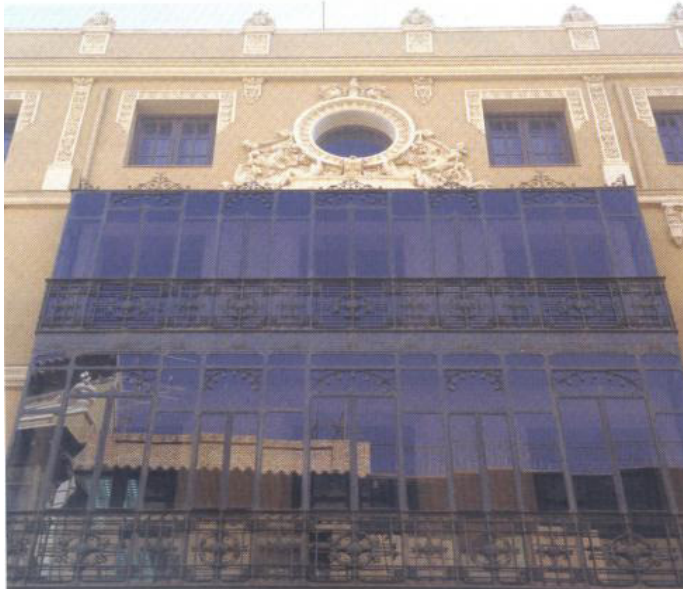
Resim 2.4. Gneř duvarı uygulanmıř rnek bir yapı
