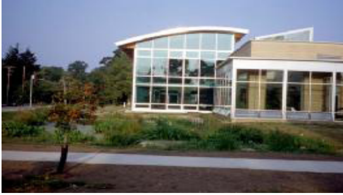
Resim 2.3. Güney duvarı pencere ile kaplanmış örnek bir yapı [40]
