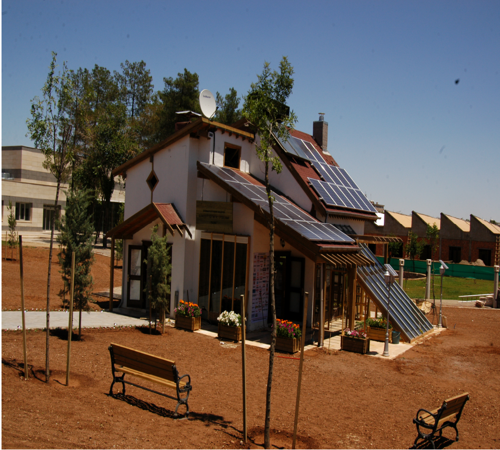
Resim 3.6. Diyarbakır Gneş Evi [78]
