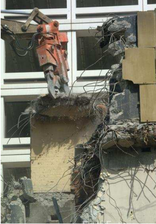
Resim 3.1. Pülverizatör eklentili ekskavatör tarafından betonarme blokların parçalanması [Freefoto, 2010]
