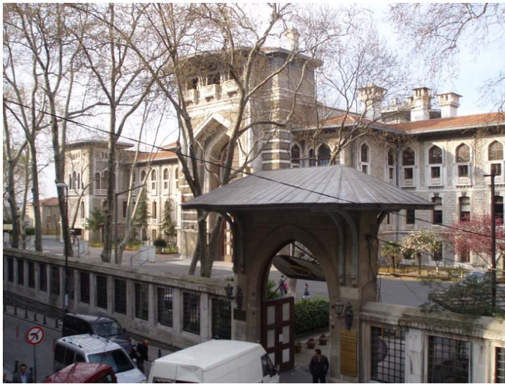
Resim 2.6. Düyun-u Umumiye İdaresi binası [Akşit, 2010]
