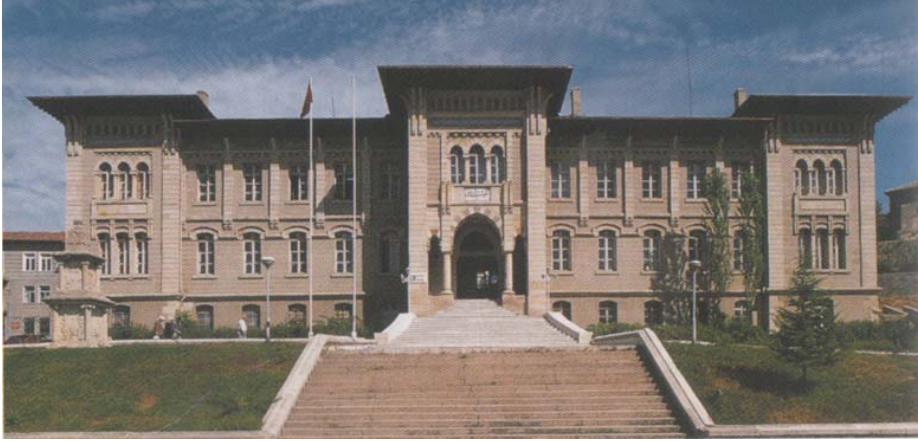
Resim 2.7. Kastamonu Hükümet Konağı [Batur, 2003]
