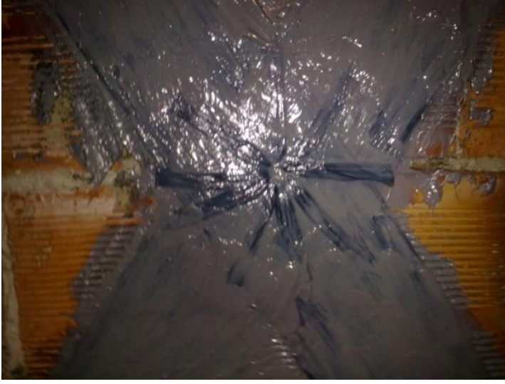
Resim 2.4. Ankraj detayı CFRP yüzeyi
