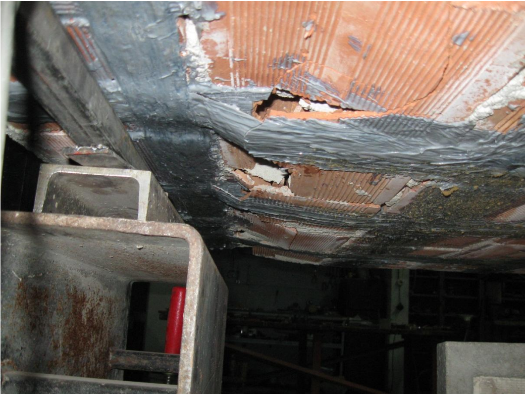
Resim 4.31. Tuğla parçalarının CFRP şeridi kesmesi
