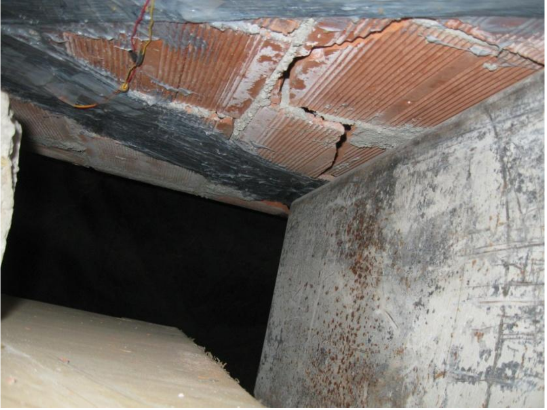
Resim 4.5. 2. sıra tuğlaların kırılması
