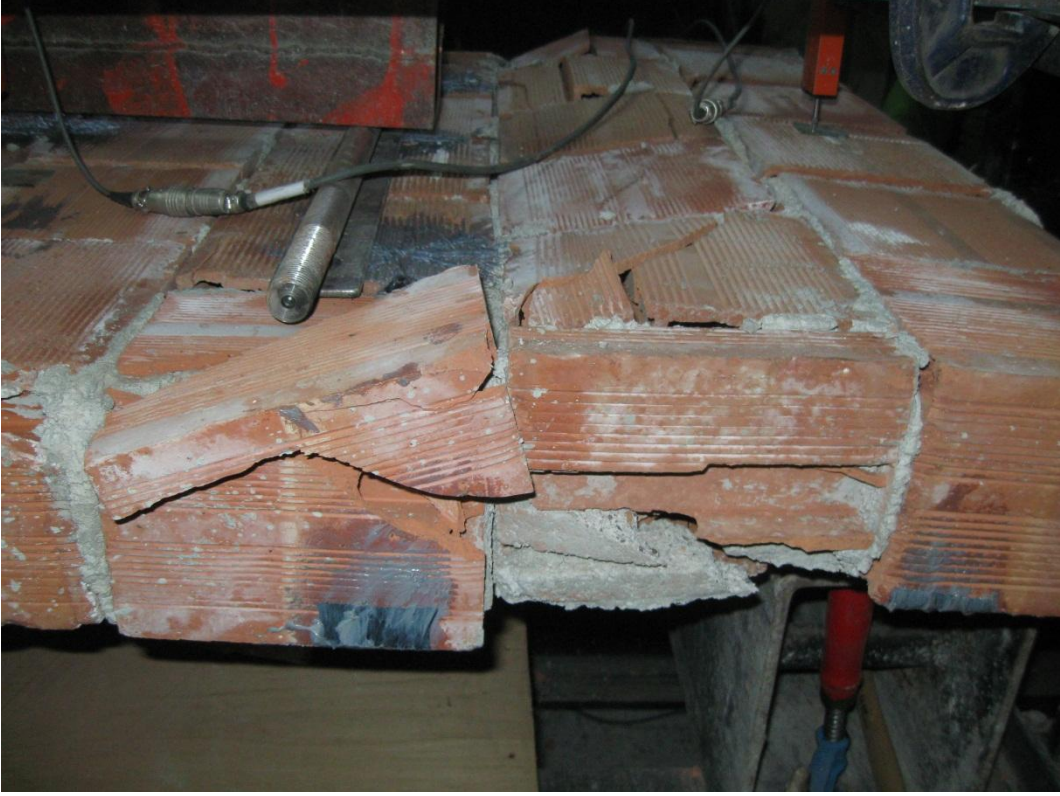
Resim 4.30. Çatlağın mesnet altından başlayıp derze doğru ilerlemeleri
