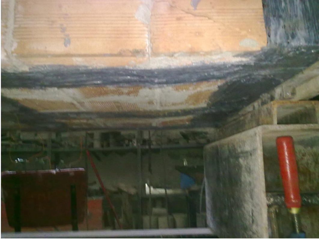
Resim 4.25. CFRP şerit yüzey aderansı
