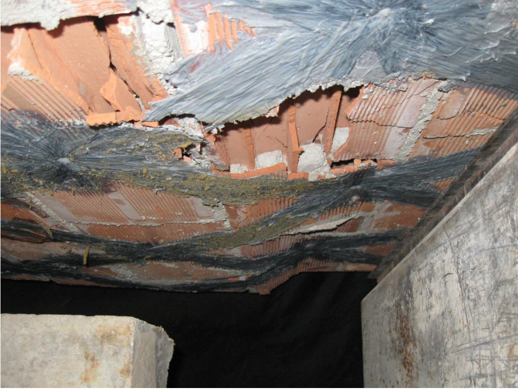
Resim 4.18. CFRP kopması
