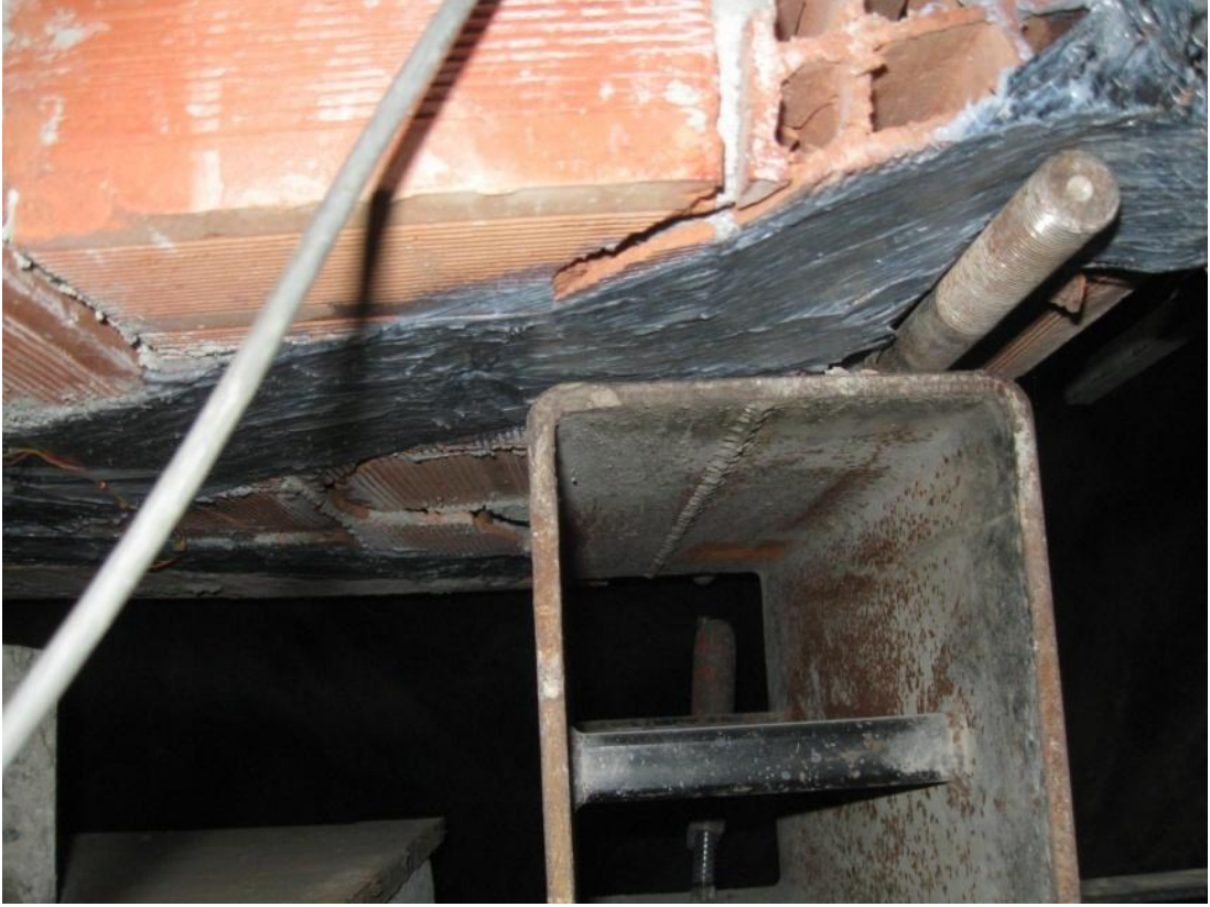
Resim 4.4. CFRP yüzeyden ayrılma
