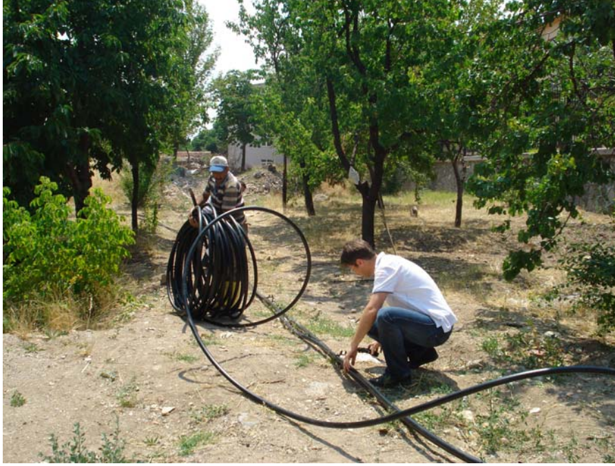
Resim 4.3. U-borusunun kuyu içerisine yerleştirmek için hazırlanışı
