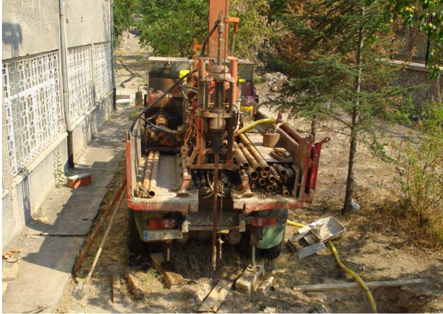
Resim 4.1. Kazı aracının fotoğrafı
