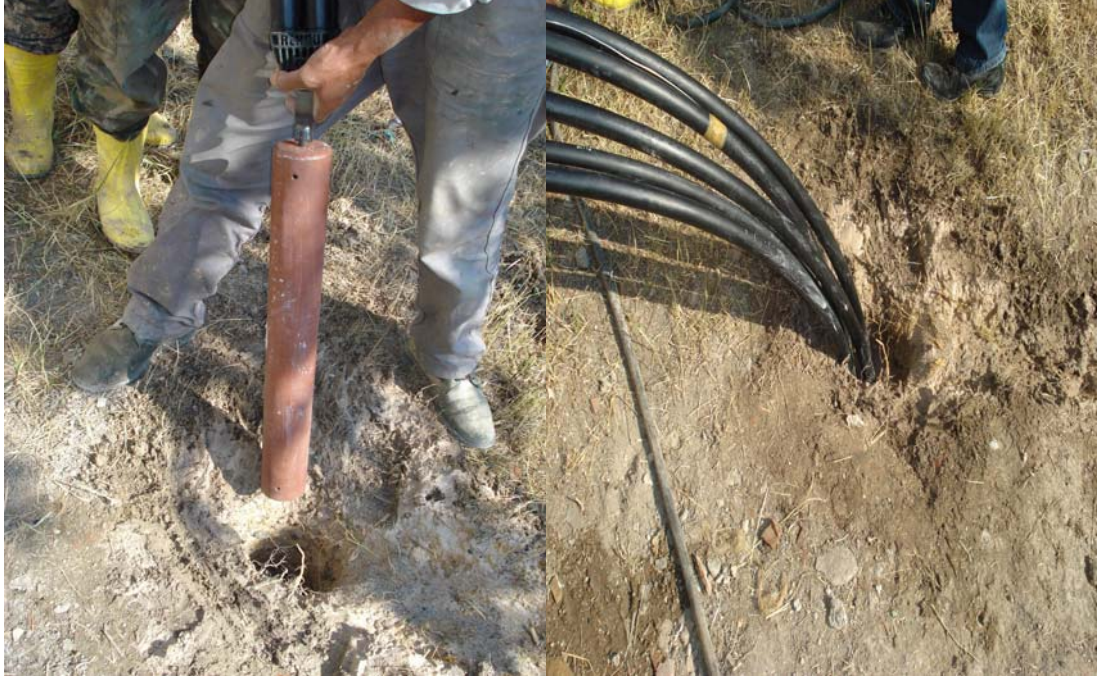
Resim 4.6. U-borusunun kuyu içerisine yerleştirilmesi
