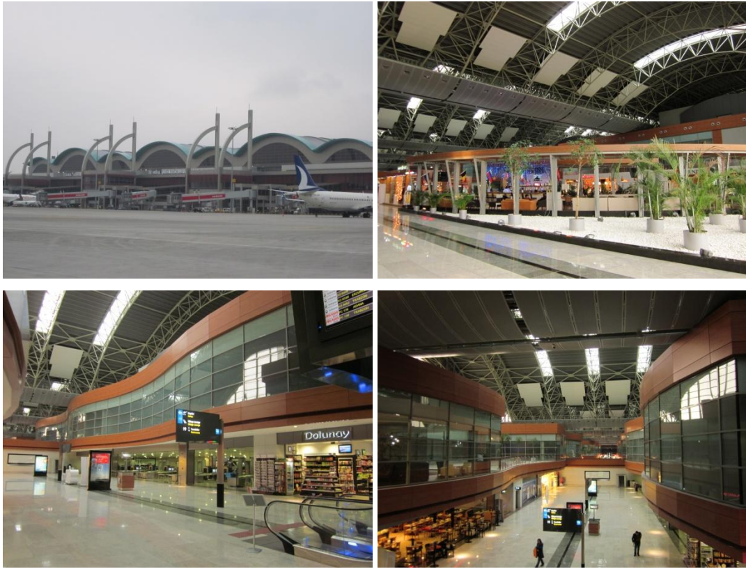
Resim 3.30. Sabiha Gökçen Havalimanı dış cephe ve giden yolcu katı görüntüleri
