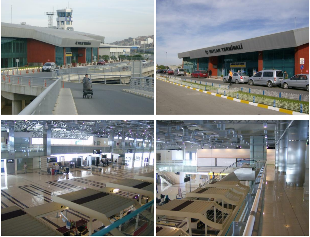
Resim 3.19. Trabzon Havalimanı dış cephe ve iç mekan görüntüleri
