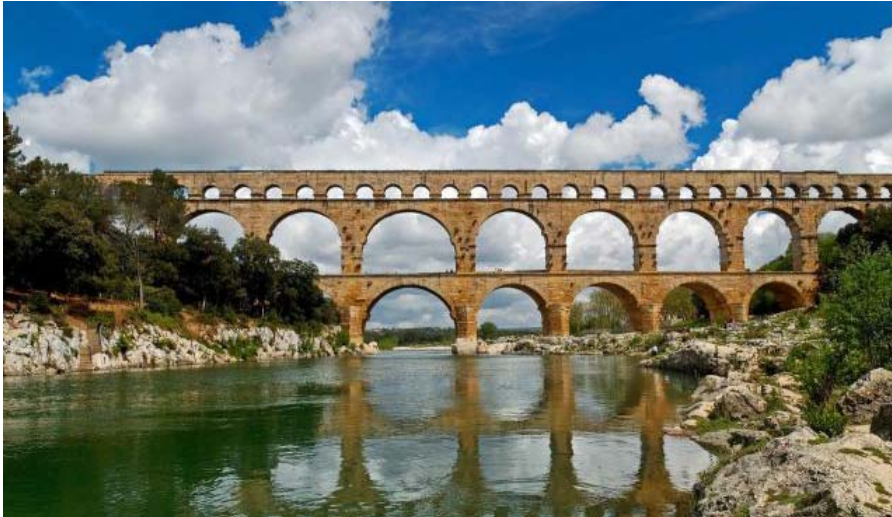
Resim 2.5. Üç farklı kemer konfigürasyonundan oluşan Pont du Gard
