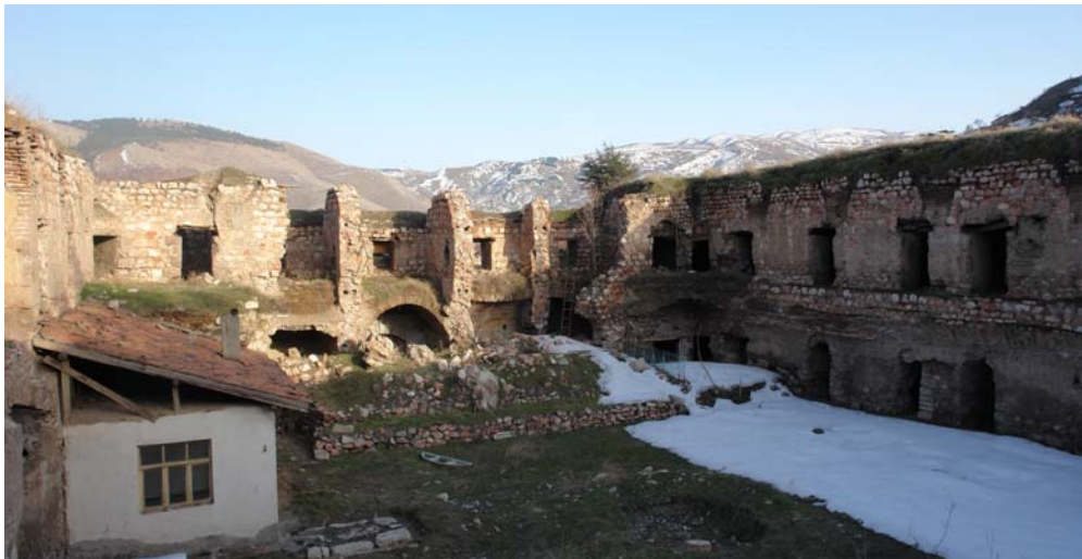
Resim 5.1. Deveci Hanının avludan görünüşü
