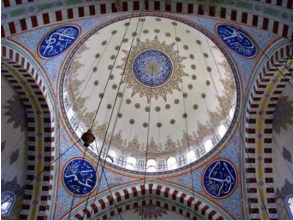
Resim 2.6. Kubbenin örttüğü karenin dışına oturan kubbede pendentif uygulaması
