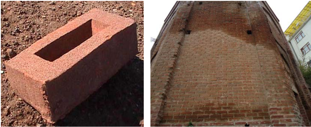
Resim 2.3. Harman tuğlası ve uygulama örneği (Niksar Kırkkızlar Türbesi)
