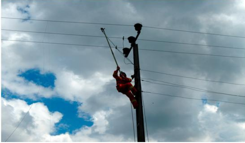
Resim 2. 3. Hat topraklama donanımı ve kullanılışı
