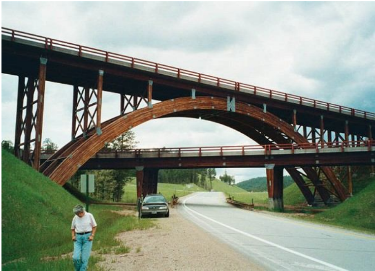
Resim 2.3. 1968 yılında inşa edilen Keystone Wye kavşak köprüsü (Üç mafsallı kemer köprü) [24]
