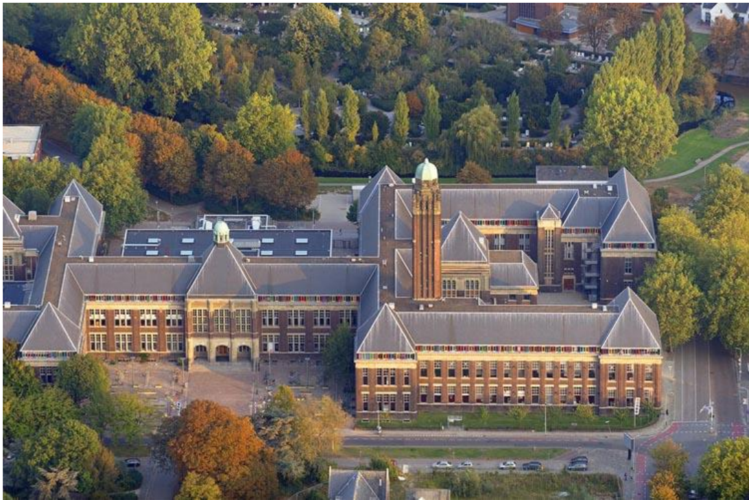
Resim 4.5. Delft Teknik Üniversitesi Mimarlık Faköltesi mevcut binası (Delft Teknik Üniversitesi arşivinden alınmıştır)
