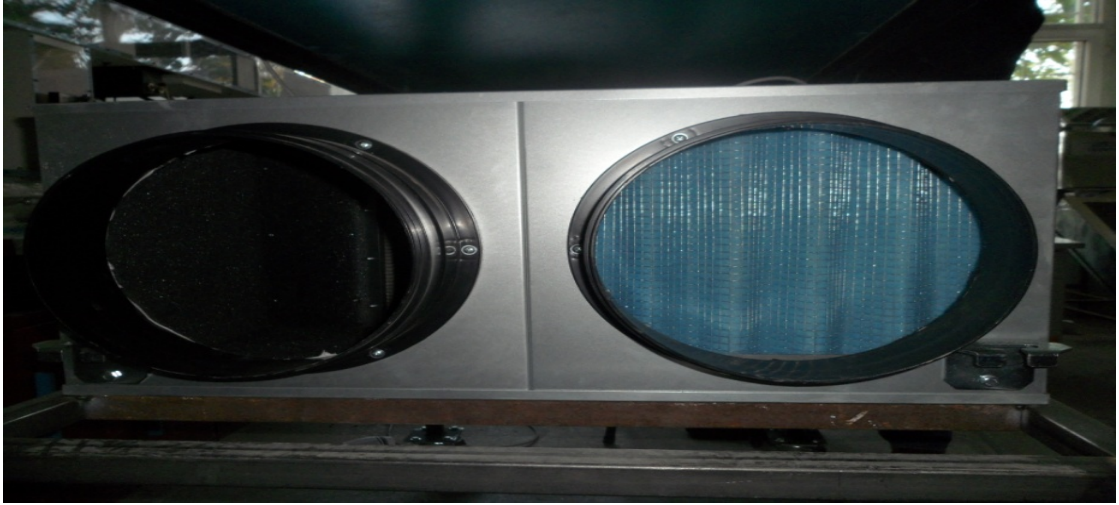
Resim 3.6. Isı geri kazanım cihazı ön görünüşü
