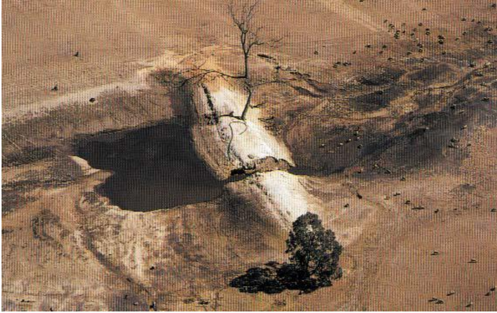
Resim 3.2.Yeterli bir dolu savagı olmadığı için bozulmuş küçük bir toprak gölet [Oweis ve ark., 2001]
