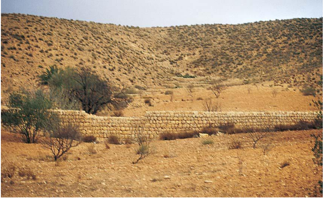
Resim 2.3Tunus'taki taş duvarlardan yapılmış geleneksel jessour sistemleri [Oweis ve ark., 2001]
