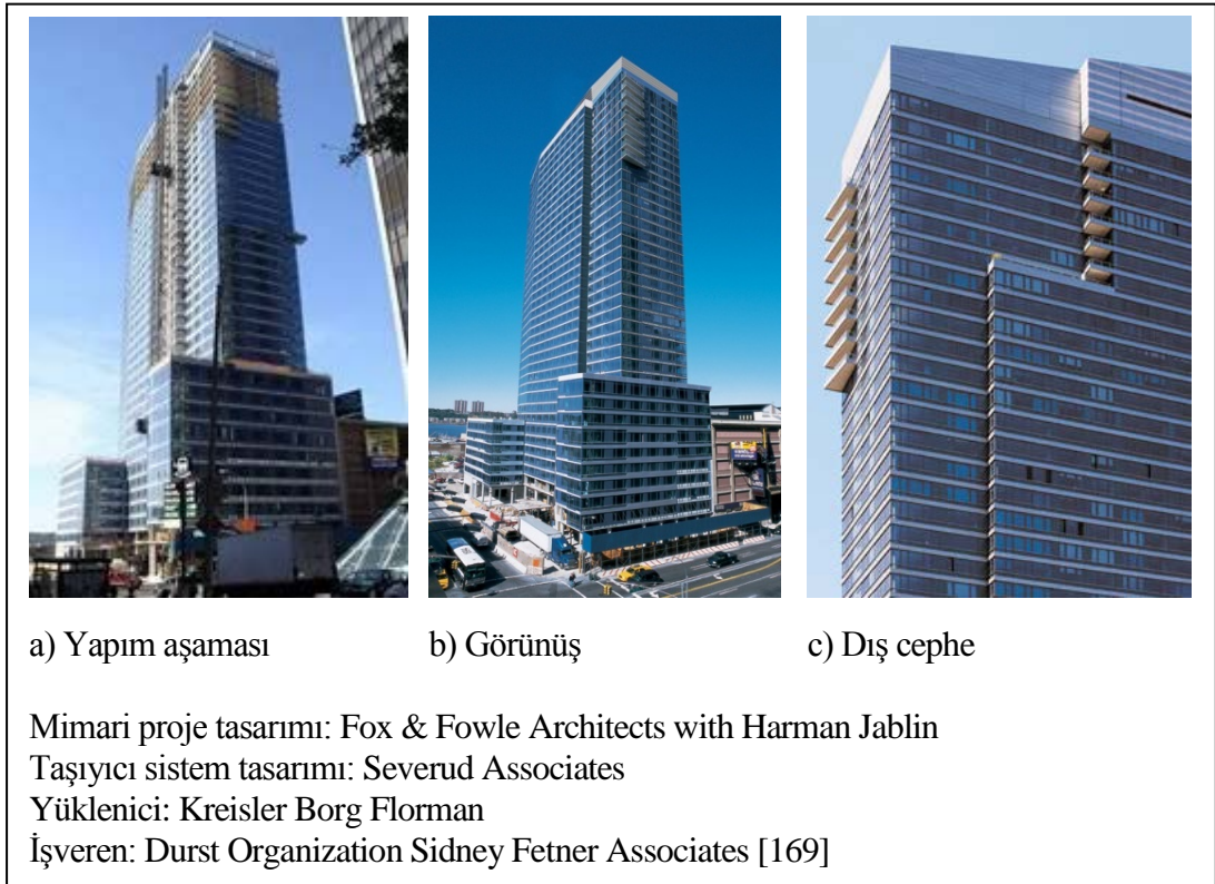
Resim 3.6. Helena Binası, New York - ABD [169 - 171]
