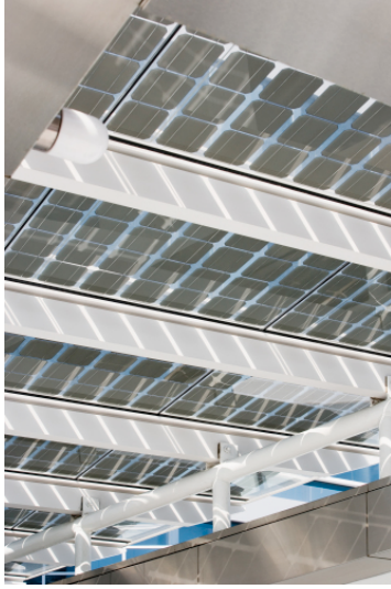
a) Bina girişindeki güneş pilleri
