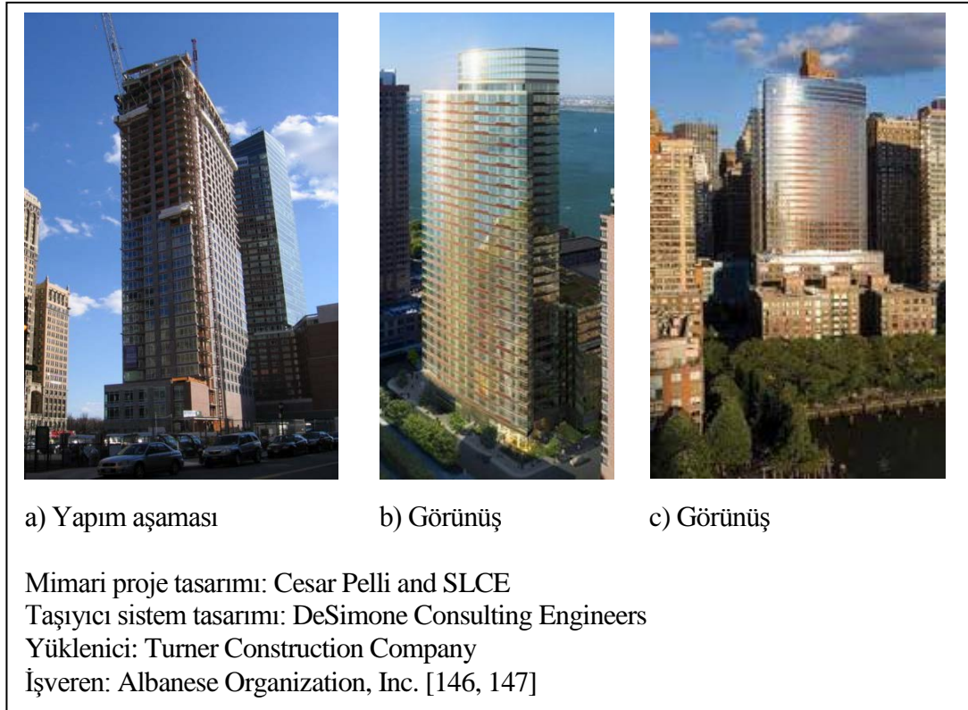
Resim 3.2. Visionaire Binası, New York - ABD [146 - 150]
