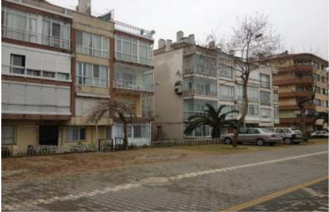
Resim 4.1. Çıkmalı ve bina yaşı yüksek yapılar
