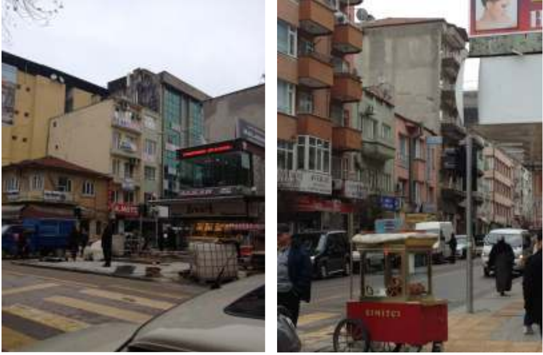
Resim 4.2. Yumuşak kat tehlikesi barındıran, bitişik nizamda kat seviyeleri farklı, bina yaşı yüksek yapılar
