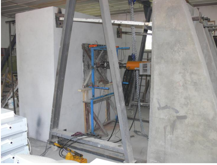
Resim 4.13. D 2 deney duvarı ve reaksiyon duvarı
