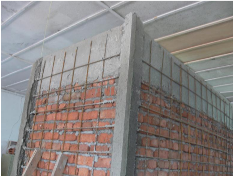
Resim 4.9. Hasır çeliklerin eklenmesi ve ankraj çubukları
