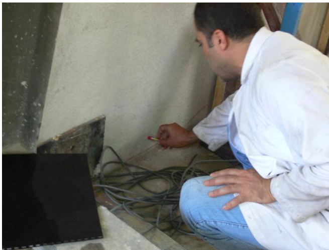
Resim 5.2. D 2 deney örneğinde +120 kN' da meydana gelen döşeme çatlağı
