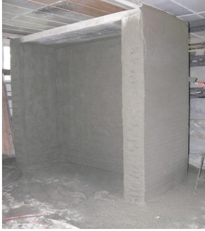
Resim 4.11. Duvarın püskürtme betonla kaplanması uygulama aşamaları a) Duvar iç yüzeyine ikinci kat püskürtme beton uygulaması b) Dış yüzeye püskürtme beton uygulaması c) Duvar iç yüzeyinin kaplanmış hali d) Duvar dış yüzeyinin püskürtme beton uygulamasının tamamlanmış hali
