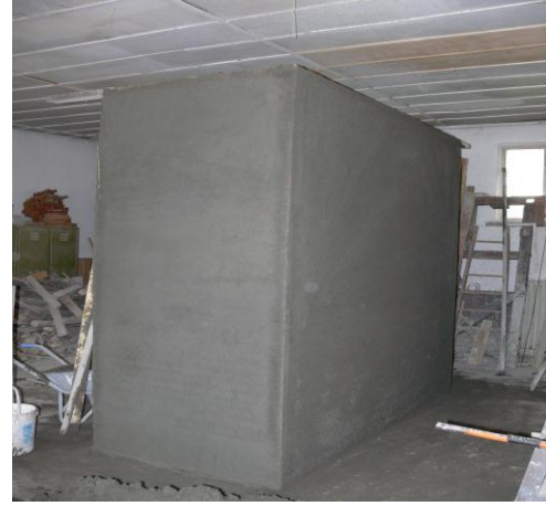
Resim 4.11. Duvarın püskürtme betonla kaplanması uygulama aşamaları a) Duvar iç yüzeyine ikinci kat püskürtme beton uygulaması b) Dış yüzeye püskürtme beton uygulaması c) Duvar iç yüzeyinin kaplanmış hali d) Duvar dış yüzeyinin püskürtme beton uygulamasının tamamlanmış hali
