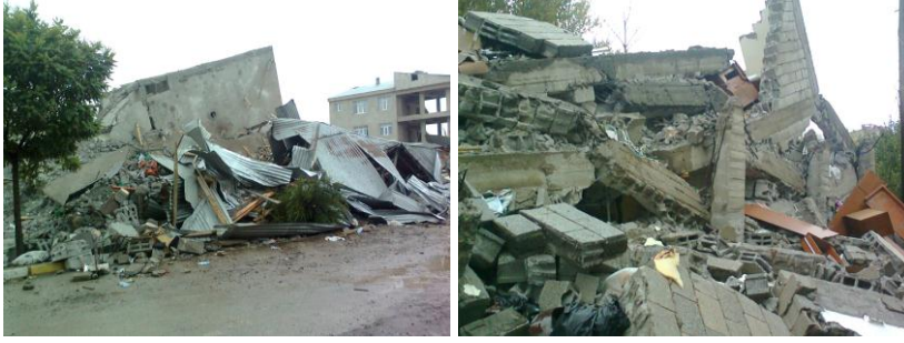
Resim 1.1. Van depreminde yıkılan binalar
