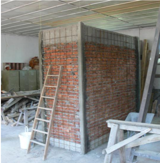
Resim 4.7. Duvar dış yüzeyinin hasır çelikle kaplanması
