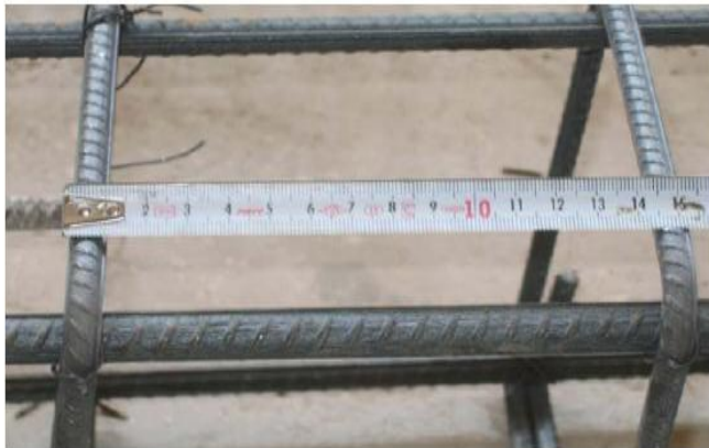
Resim 4.4. 12’ lik hatıl donatısı ve 8’lik etriyeler
