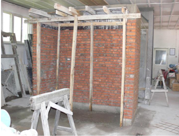
Resim 4.5. Hasır çelikle kaplanacak duvar
