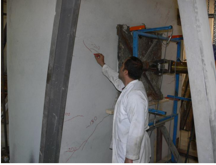
Resim 5.4. -200 kN' luk uygulanan çekme kuvveti ile dış yüzeyde oluşan çatlaklar
