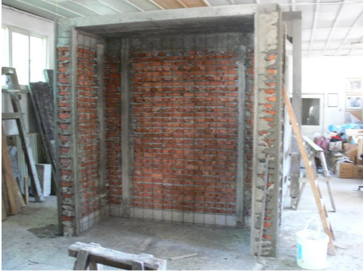
Resim 4.6. Duvar iç yüzeyinin hasır çelikle kaplanması
