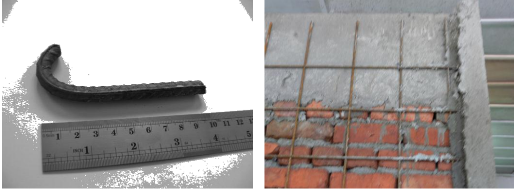
Resim 4.8. Hasır çeliğin ankraj çubukları ile duvara bağlanması ve çubukların hatıl ve duvara montajı a) Ankraj çubuğu b) Hasır çeliğin ankraj ve montajı tamamlanmış hali
