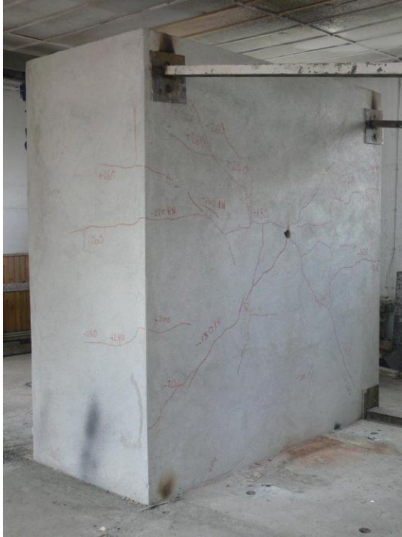
Resim 5.9. D 2 deney örneğinde deney sonucunda dış yüzünde oluşan çatlaklar
