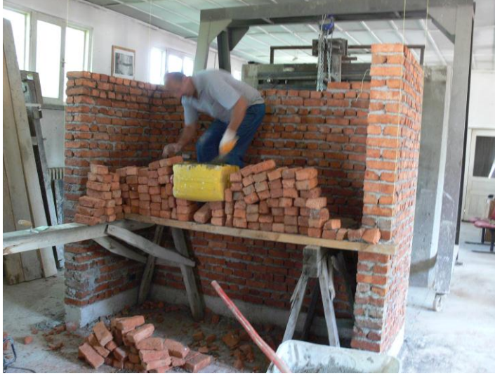
Resim 4.3. Tuđla duvarın rlmesi
