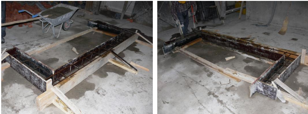
Resim 4.2. Döşeme üzerine inşa edilen betonarme hatıl
