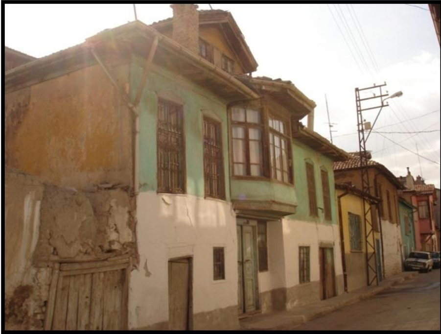
Resim 4.4. Piri Mehmet Paşa Mescidi civarındaki evin çıkmasının altı ahşap kaplanmıştı (F. Nur ODUNCU, 2013).
