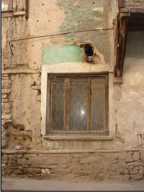
Resim 3.60. Kuzey cephe P2 penceresi
