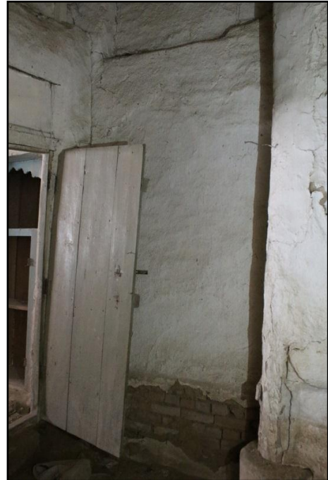
Resim 5.3. Z 02 depodan tuğla örülmüş duvarın görüntüsü
