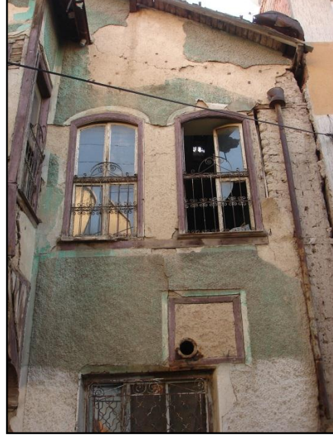
Resim 3.63. Kuzey cephe P5 penceresi
