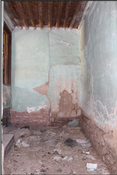
Resim 5.2. Z 06 sofadan tuğla örülmüş duvarın görüntüsü
