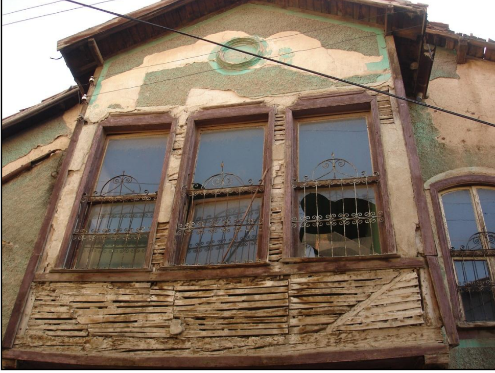
Resim 3.62. Kuzey cephesi çıkma duvarı ve pencereleri
