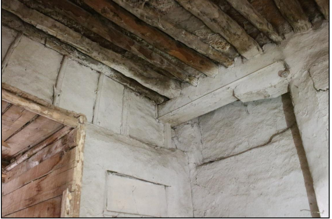
Resim 5.4. Z 02 depodaki ahşap kiriş
