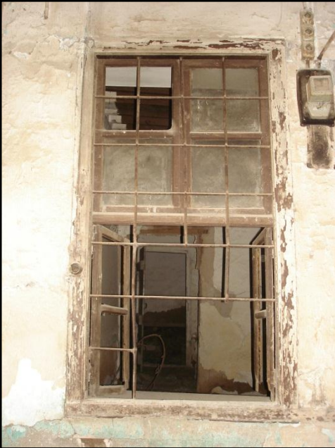
Resim 3.68. Doğu cephesi P1 Penceresi
