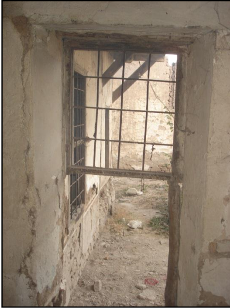
Resim 3.15. Z 05 kapı boşluğu
