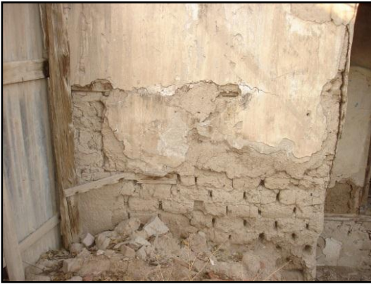
Resim 3.71. Güney cephesi duvar detayı
