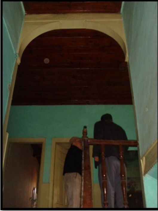
Resim 4.3. İç mekânda bulunan merdiven ve sofaya girişte bulunan kemer (F. Nur ODUNCU, 2013).
