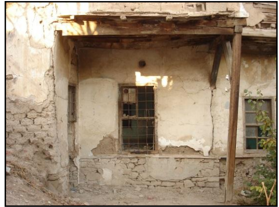
Resim 3.72. Güney cephesi P3 penceresi
