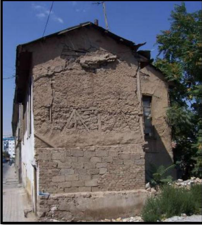
Resim 4.7. Türbe mahallesindeki bir evin yan cephesindeki kerpiç sıva (Sürdürülebilir Mimarlık Bağlamında Geleneksel Konya Evi Üzerine Bir İnceleme, A. C. KUŞÇU, Y. Lisans Tezi, 2006)
