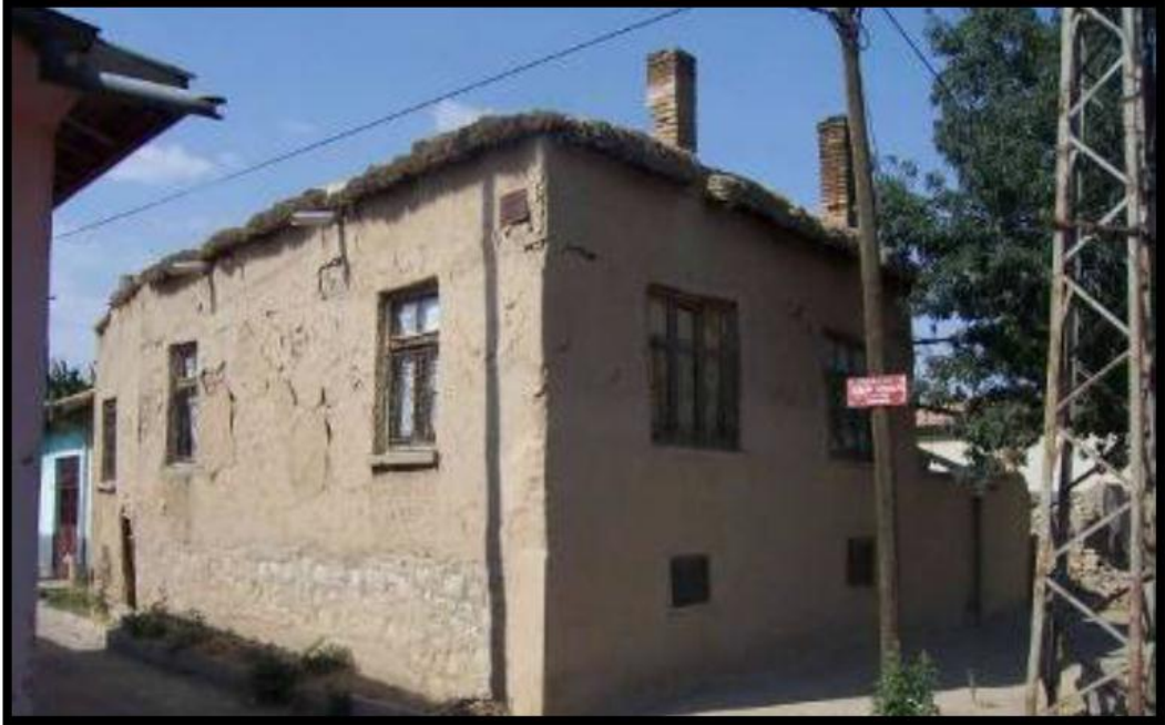
Resim 4.10. Sedirler caddesi Âşık Paşa sokaktaki evin sazdanan yapılmış çatısı (Sürdürülebilir Mimarlık Bağlamında Geleneksel Konya Evi Üzerine Bir İnceleme, Mimar Ahmet Cemil KUŞCU, Yüksek Lisans Tezi, 2006).
