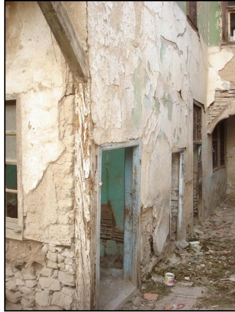
Resim 3.65. Doğu cephesi kapıları
