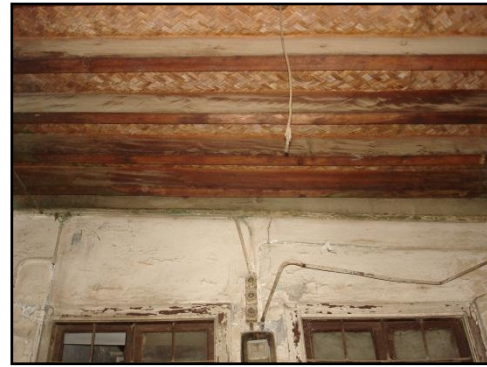
Resim 3.69. Doğu cephesi giriş giriş sistemi
