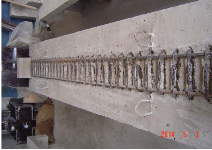
Resim 3.7. Çok donatılı elemanlarda etriye kollarının kaynaklanması
