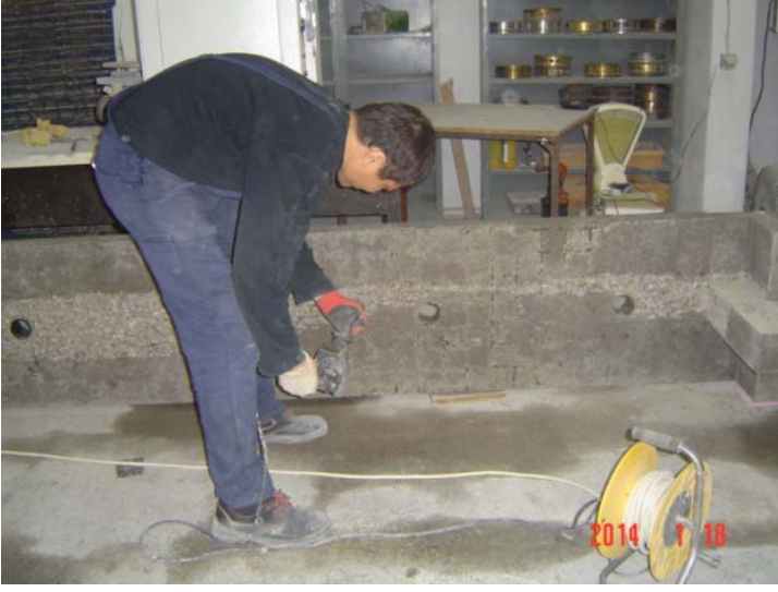
Resim 3.5. Döşeme deliklerinin açılması
