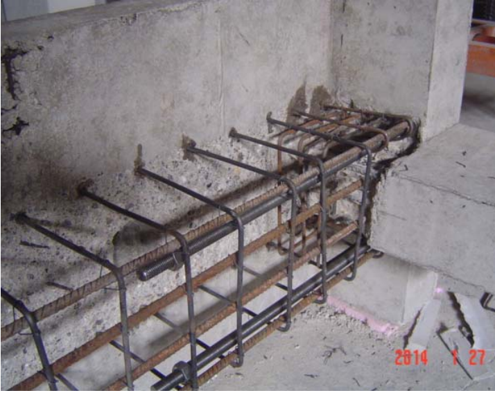
Resim 3.6. Etriye ve kolon bağlantı elemanlarının hazırlanması
