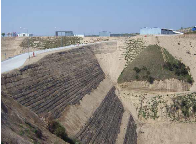
Şekil 4.5. Bohçalama uygulaması yapılmış bir dolgu şev yüzeyi (İnternet 12)
