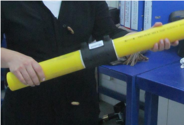
Resim 4.7. Kaynak işlemi gerçekleştirilecek boruların maşon içerisine yerleştirilmesi
