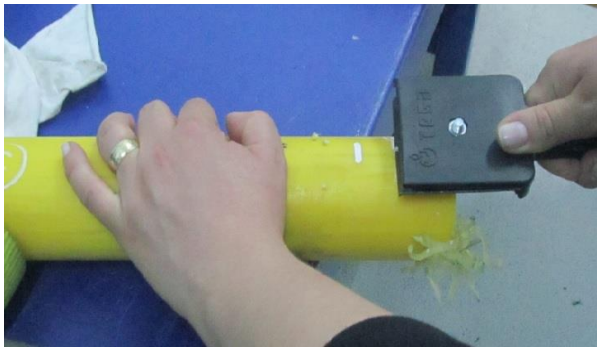
Resim 4.5. Mařon kalınlıęı kadar kaynak aęzının kazıyıcı ile tırařlanarak temizlenmesi
