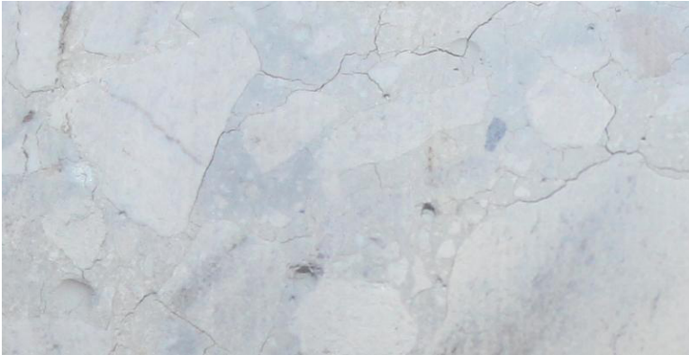
Resim 4.2. 700 °C havada soğutulan örnekte çatlak dağılımları
