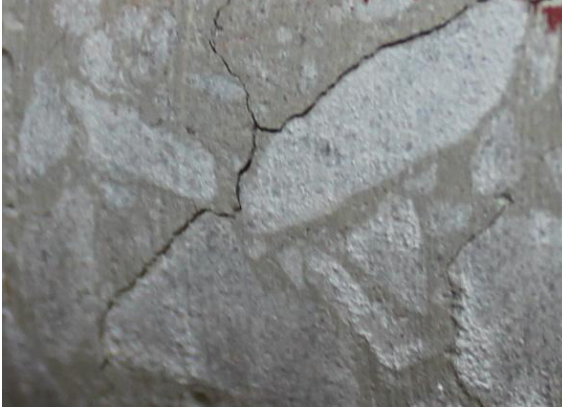
Resim 4.1. 700 °C havada soğutulan örnekte ara yüzeyde çatlak görünümü
