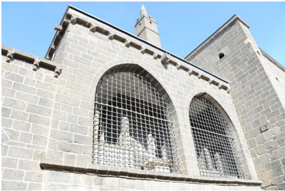
Resim 4.7. Diyarbakır İç Kale Camisi'nin hazire bölümünde yer alan sivri kemerli açıklıklar (Yasemin Baran arşivi,2014)
