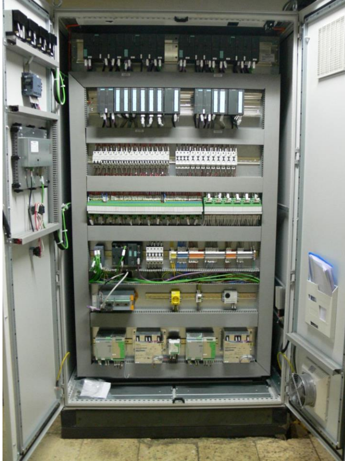
Şekil 2.20. Gezende HES’de kullanılan elektronik hız regülatörü
