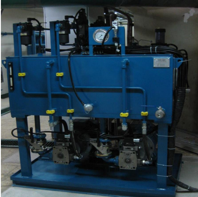
Şekil 2.21. Gezende HES’de kullanılan basınçlı yağ sistemi
