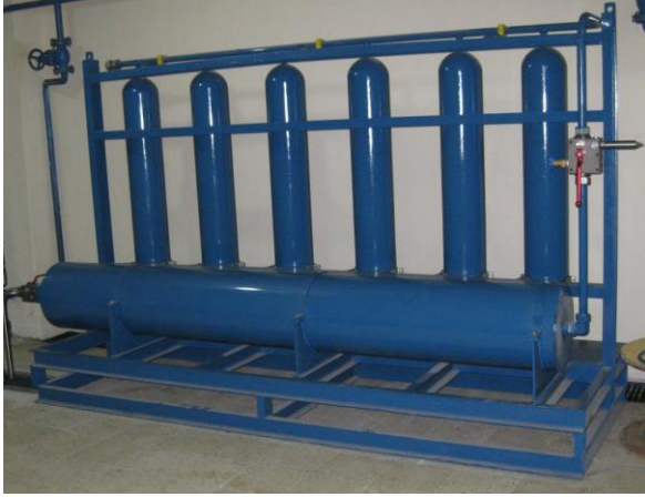
Şekil 2.22. Gezende HES’de kullanılan basınçlı tank
