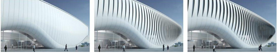
Şekil 3.7. Tematik Pavilyon kinetik cephe pozisyonları [47]
