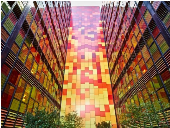
Resim 2.2. Alüminyum kompozit levha örneği, CSP Mimarlık, Sunday apartmanı [14]
