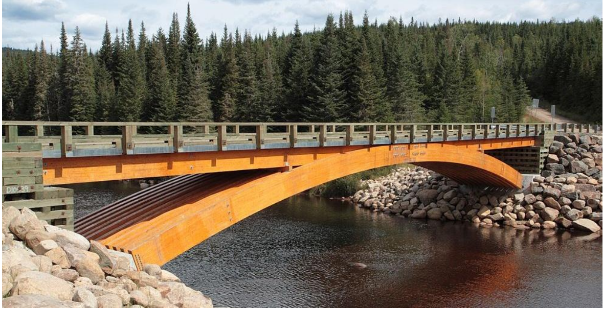
Resim 2.1. Montmorency Nehri üzerinde bulunan tutkallanmış lamine kereste köprü uygulaması (Wikimedia, 2015)
