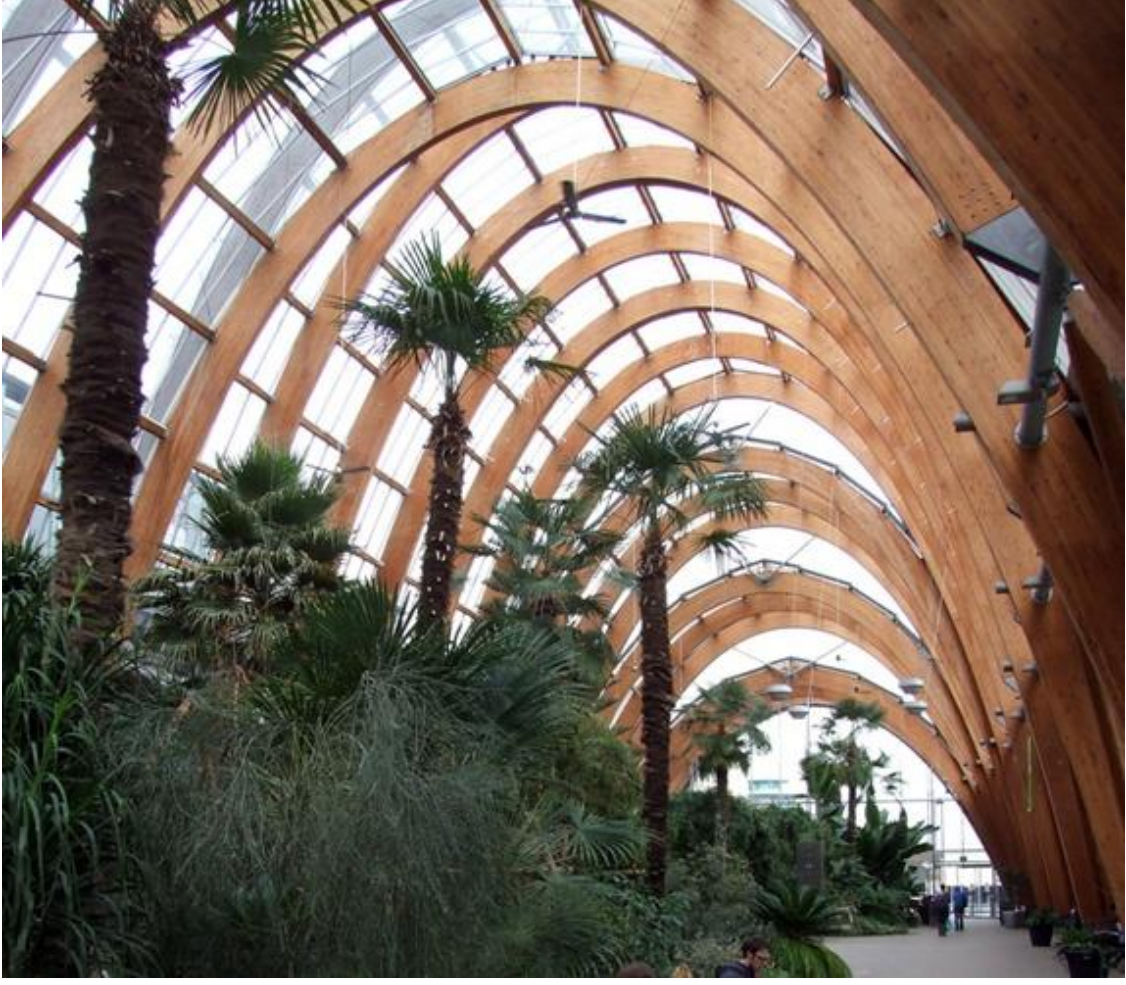
Resim 2.3. Sheffield Kış Bahçeleri tutkallanmış lamine kereste uygulaması (Stanbridge, 2015)
