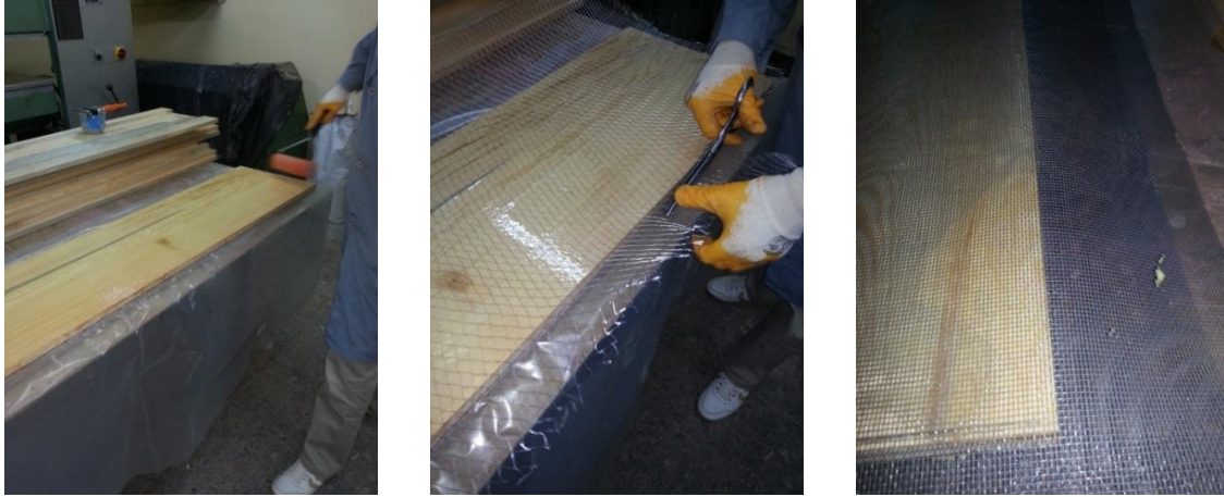
Resim 4.7. Destek elemanlarının katmanlar arasına yerleştirilmesi.
