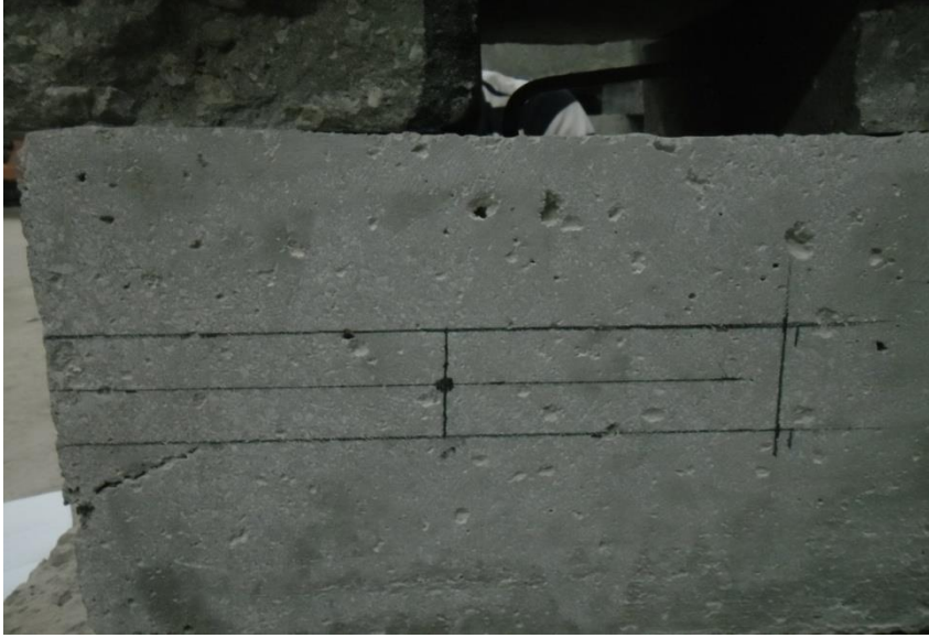
Resim 3.3. CFRP şeritlerin yerleşim bölgelerinin işaretlenmesi
