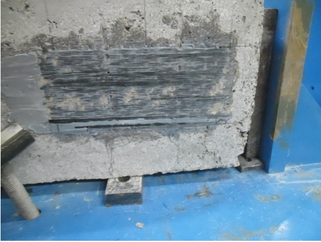
Resim 5.45. Deney elemanı 100W200L2F göçmeden sonraki görünüşü
