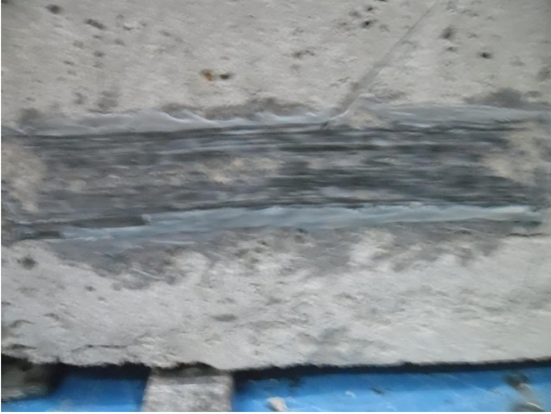
Resim 5.39. Deney elemanı 50W280L1S göçmeden sonraki görünüşü
