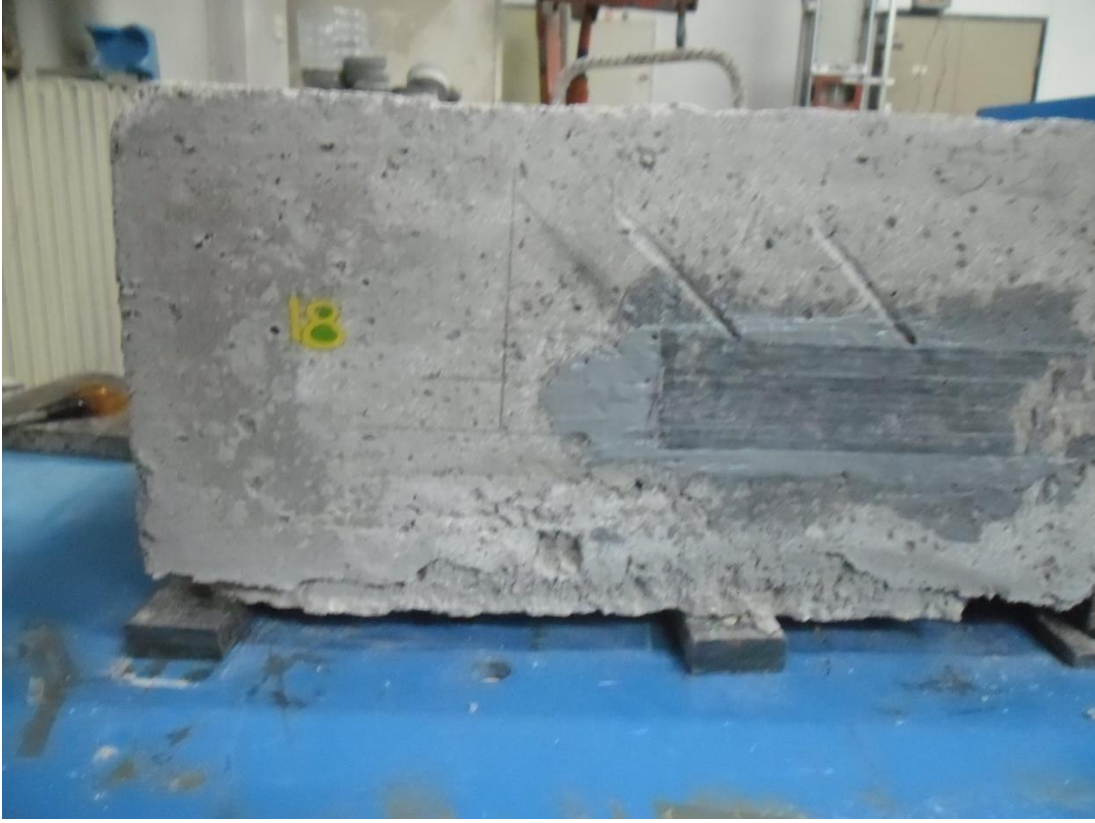
Resim 5.33. Deney elemanı 50W200L2S göçmeden sonraki görünüşü
