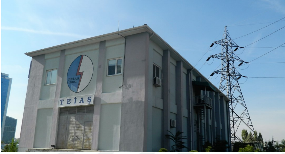
Resim 1.1. Bitkilerin yetiştirildiği trafo merkezi
