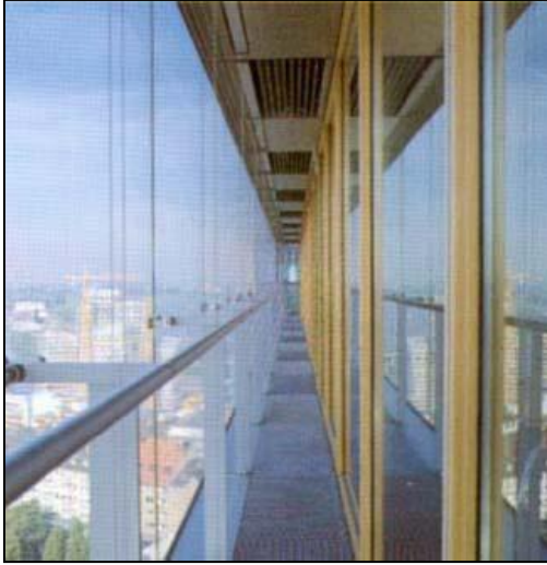
Resim 3.13. Koridor tipi çift kabuk cephe örneği [17]
