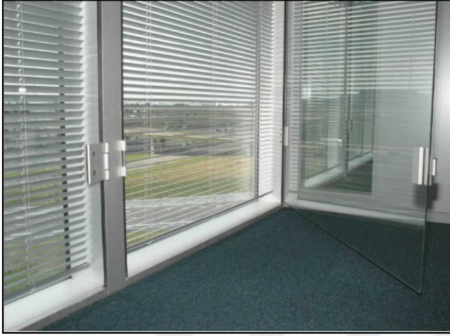
Resim 3.12. Kutu tipi çift kabuk cephe iç mekan görüntüsü [17]
