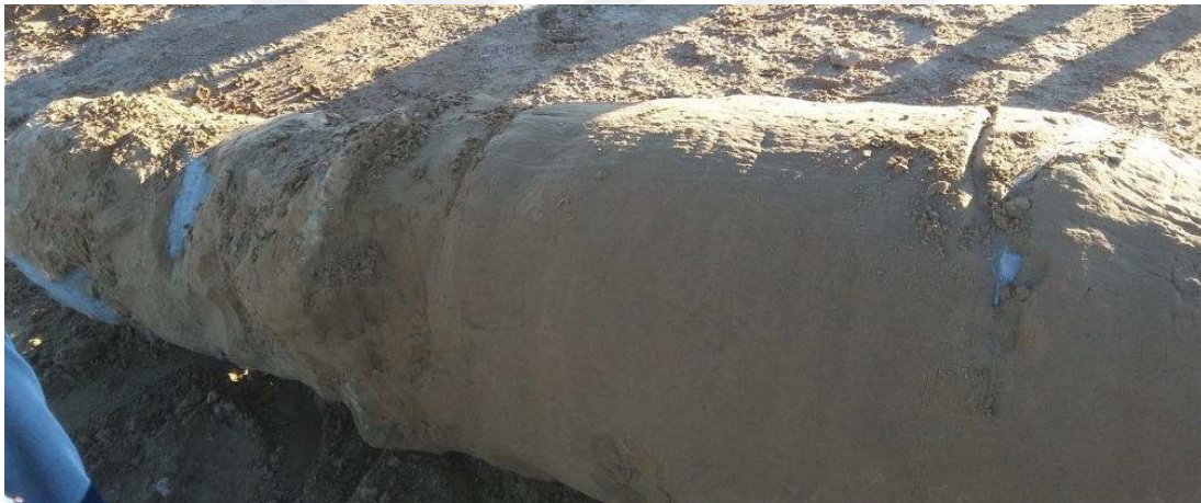
Resim 2.1. İmalat sonrası çap kontrolü amacıyla zeminden çıkartılan jet enjeksiyon kolonu
