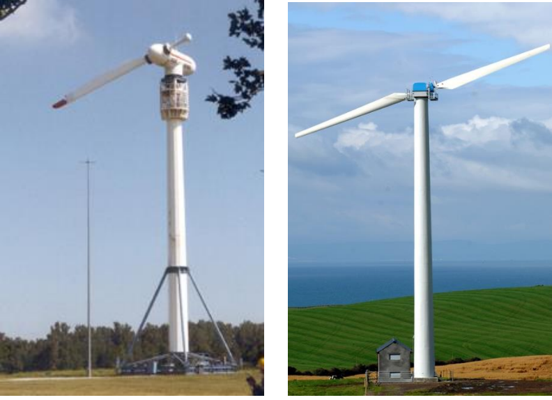
Şekil 3.5. Tek kanatlı ve iki kanatlı rüzgâr türbini
