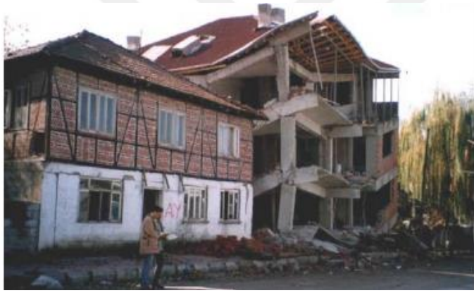
Şekil 2.5. 1999 depreminde hasar görmüş ahşap ve betonarme yapı (Doğangün ve diğerleri, 2005)
