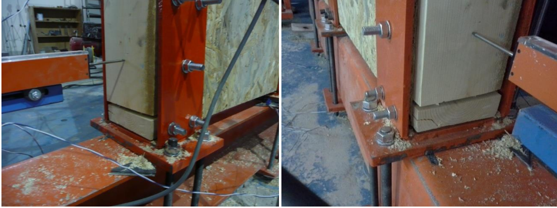
Şekil 4.15. Model-1’de meydana gelen hasarlar
