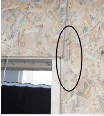
c) Panel kenarlarında ayrılmaların olması
