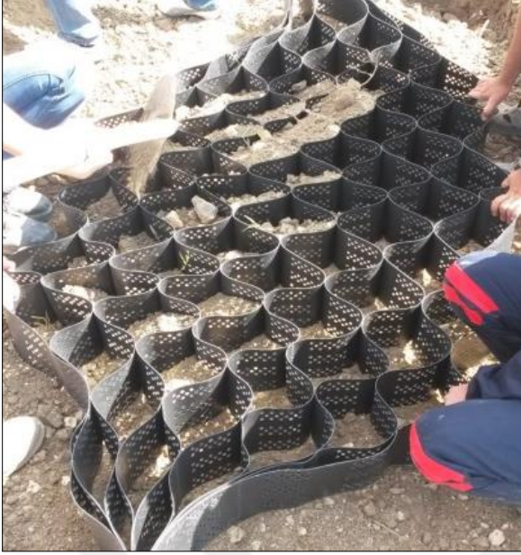
Resim 4.6. Arazi çalışmalarında güçlendirme elemanı olarak yerleştirilen geocell
