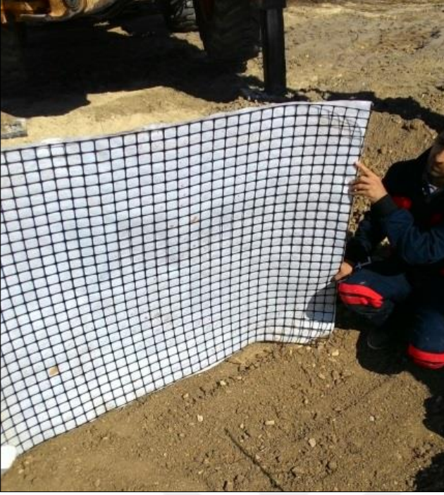
Resim 4.13. Geogrid kompozit uygulanması
