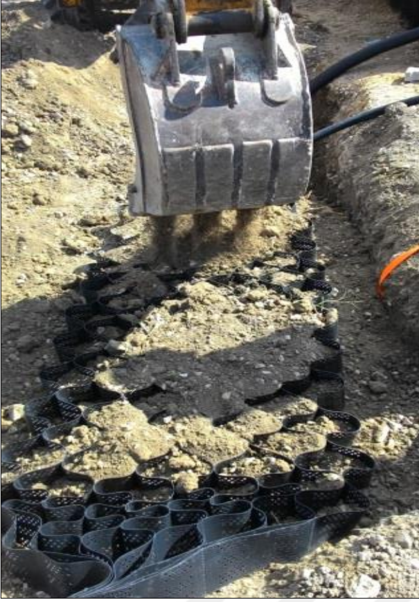
Resim 4.12. Geocell (h=150 mm, t=1,2 mm, w=330 mm) uygulanması
