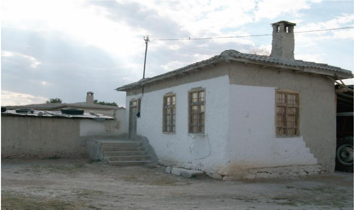
Şekil-11: Barana odasının yan cepheden görünüşü
