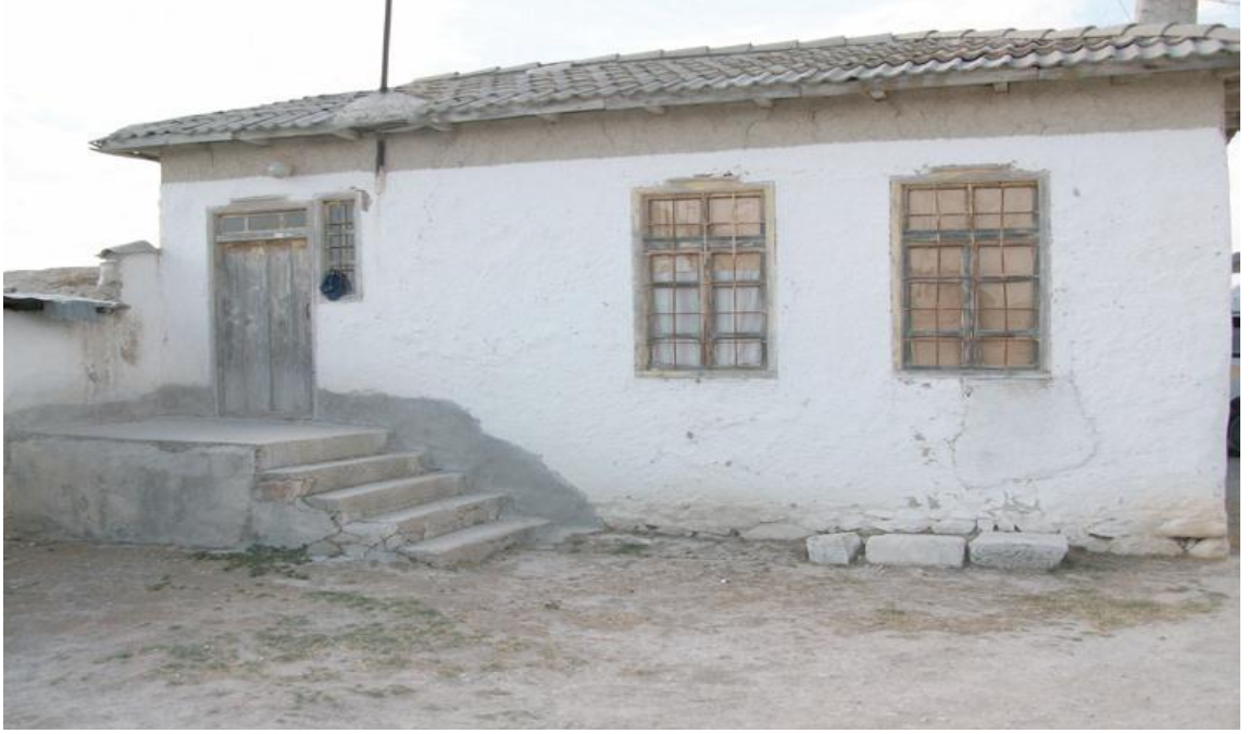
Şekil-10: Barana odasının ön cepheden görünüşü
