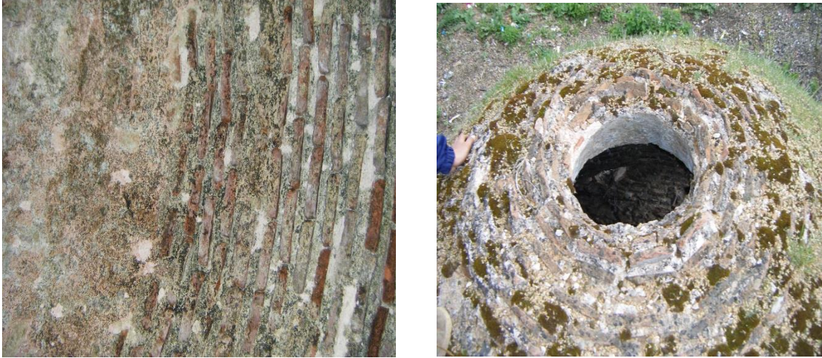
Resim 3.7. Sungurpaşa hamamı sıcaklık kubbesinin iç ve dış görünümü
