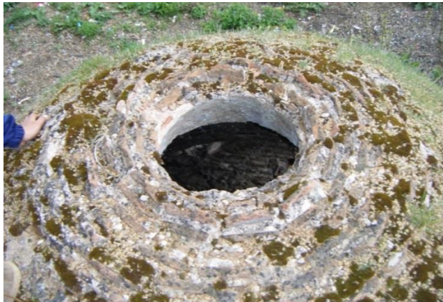
Resim 2.1. Bitki oluşumunun hamam kubbesinde yapmış olduğu tahribat (İnegöl/Bursa)
