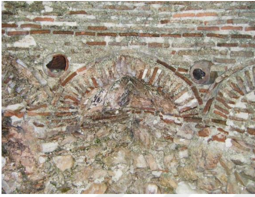
Resim 3.5. Sungurpaşa hamamı ılıklik bölümü duvar ve tromp birleşimi
