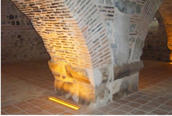
Resim 2.3. Tarihi Ortaköy Kervansarayında kireç harçları ile yapılan onarım örneği
