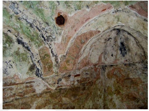
Resim 3.5. Sungurpaşa hamamı ılıklik bölümü duvar ve tromp birleşimi
