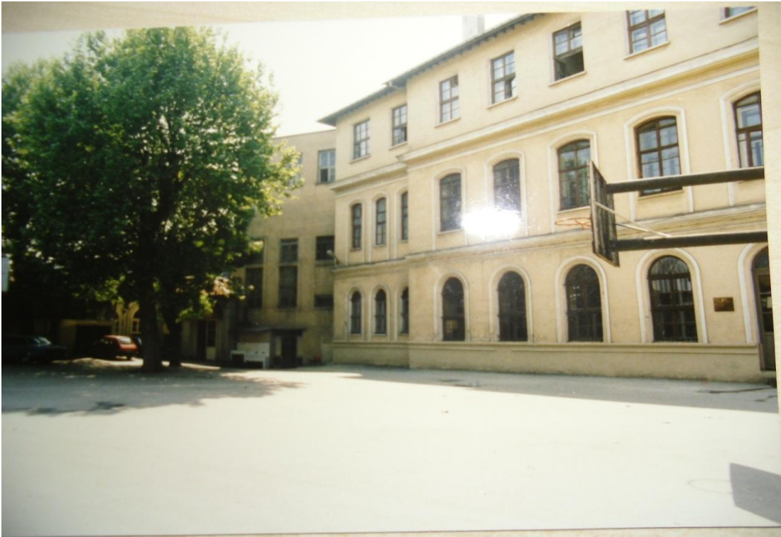
Ek-B.7: Eski Bina Pavyon Kısımı (1990)
