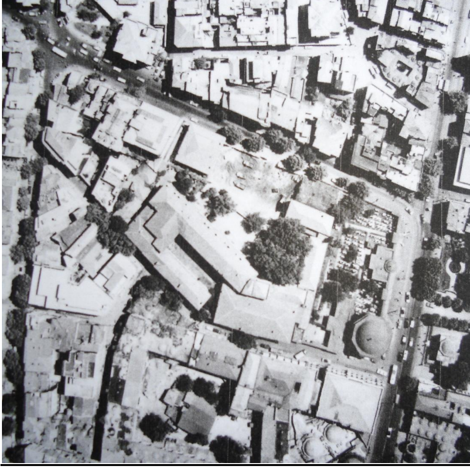
Ek-B.1: Okulun Kompleksine Ait 1966 Tarihli Hava Fotoğrafi (Cağaloğlu Anadolu Lisesi Rölöve Raporu, 2011).
