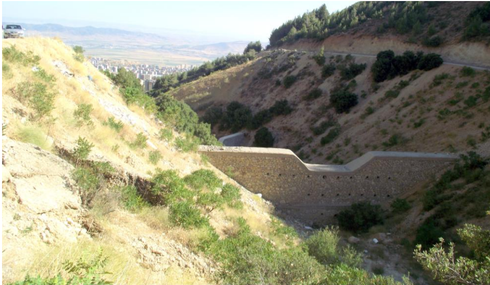
Foto 47: Ahırdağı Güney Yamaçlarına İnşa Edilmiş Tersip Bendleri
