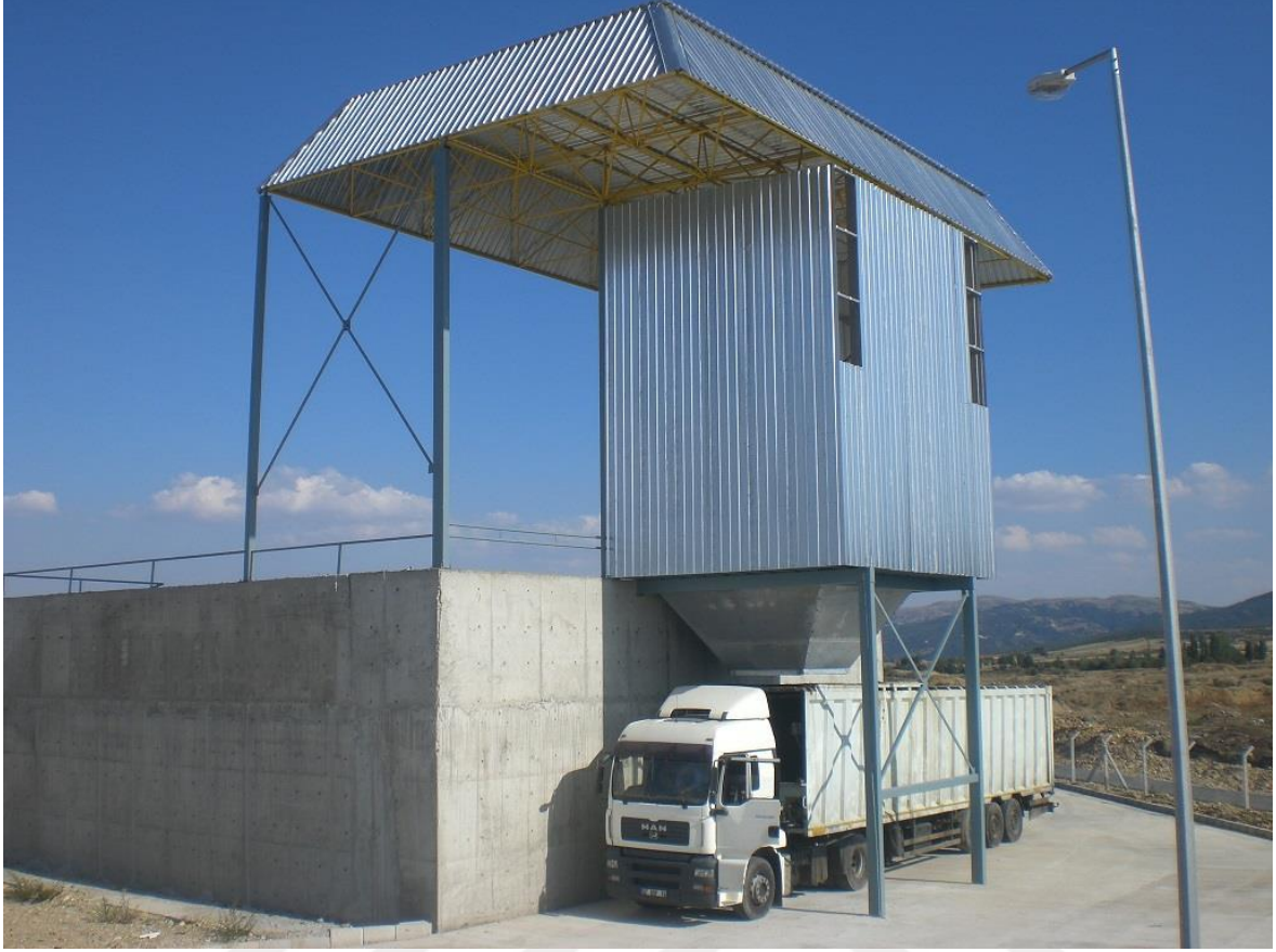
Resim 2.3. Katı atık transfer istasyonu
