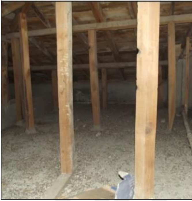
Resim 7.47. Hükümet Konağı çatı da ahşap uygulamalar
