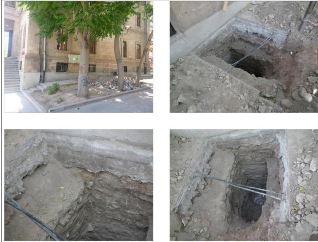
Resim 7.48. Adliye Jandarma Binası temel tahkik çukuru kazısında moloz taş uygulaması
