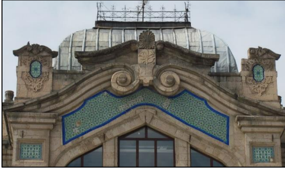
Resim 7.43. Hükümet Konağı giriş çıkmasında yer alan alınlık aynalı tonoz çatı
