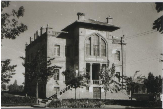
Resim 6.75. Aksaray Defterdarlık Binası [124]
