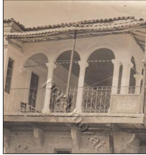
Resim 7.16. Türk Ocağı Binası kemer sütun, taş konsol
