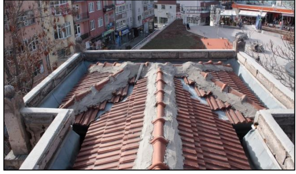
Resim 7.44. Adliye ve Jandarma Binası çatı
