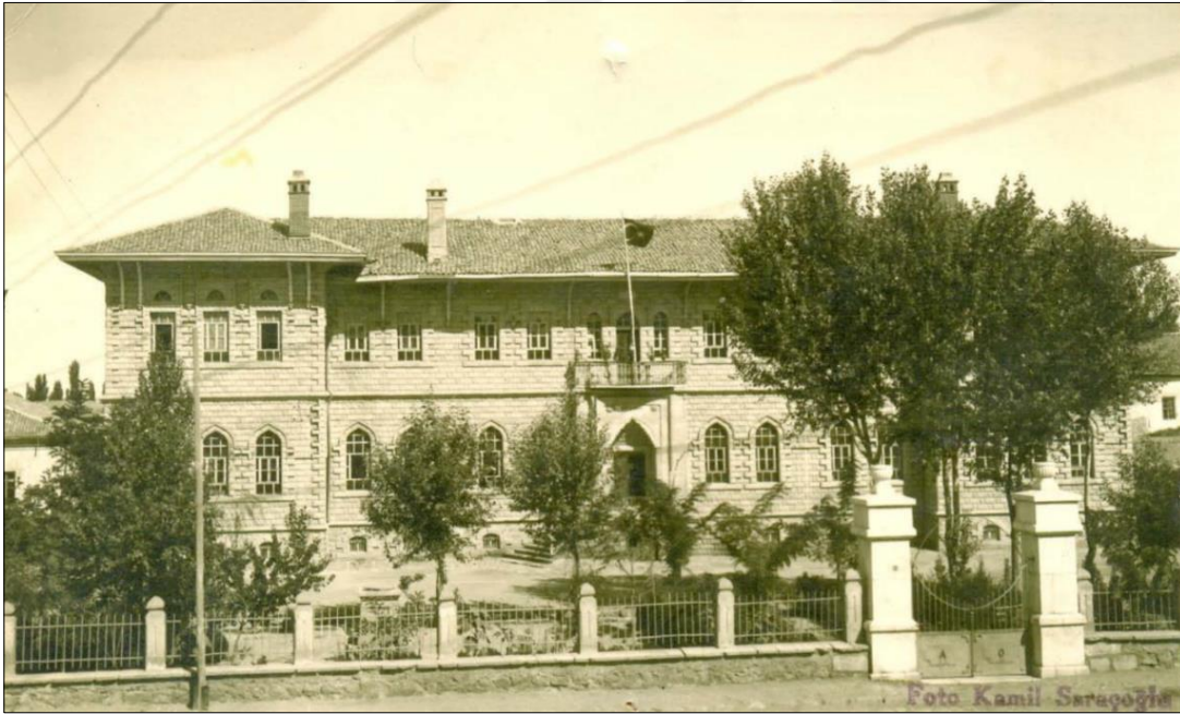
Resim 6.31. Aksaray Orta Mektep (lise) doğudan görünüş [124]
