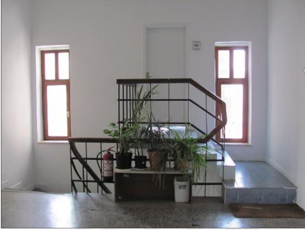
Resim 6.73. Adliye ve Jandarma İdare Binası birinci katındaki ıslak hacim
