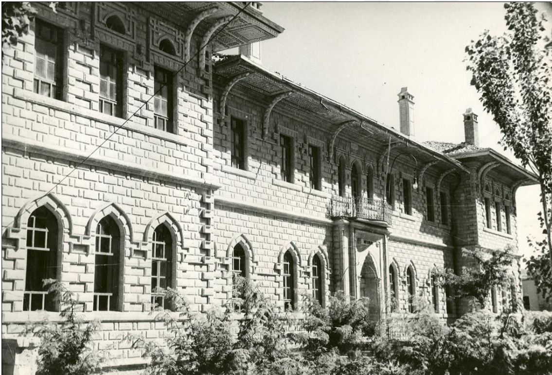
Resim 6.33. Aksaray Orta Mektep (lise) ön cephe görünüşü 1953 [128]
