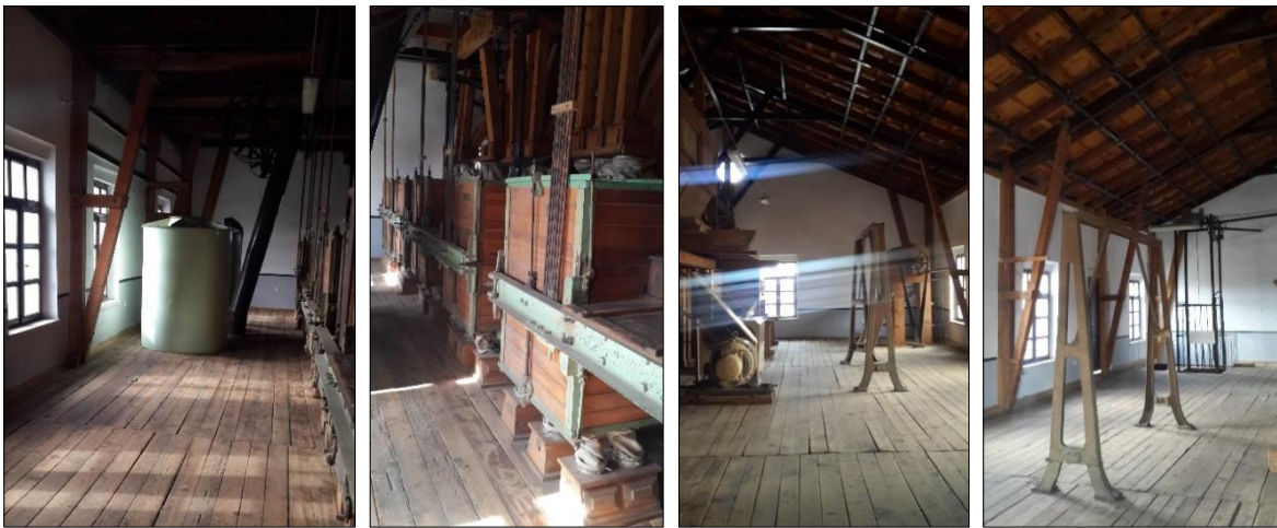
Resim 6.45. Azm-i Milli Un Fabrikası dördüncü katı (elek) katı 2017
