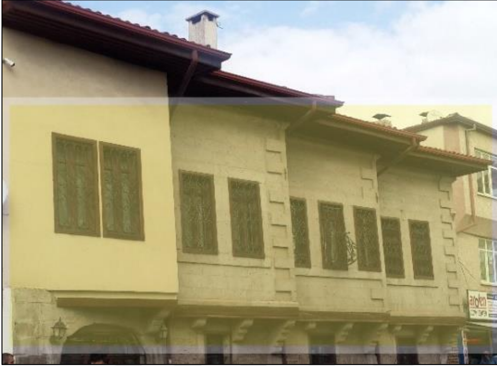
Resim 7.7. Yollar İdaresi Binası gönyeli çıkma 18
