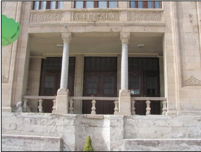
Resim 7.17. Hükümet Konağı portiko, korkuluk, sütun
