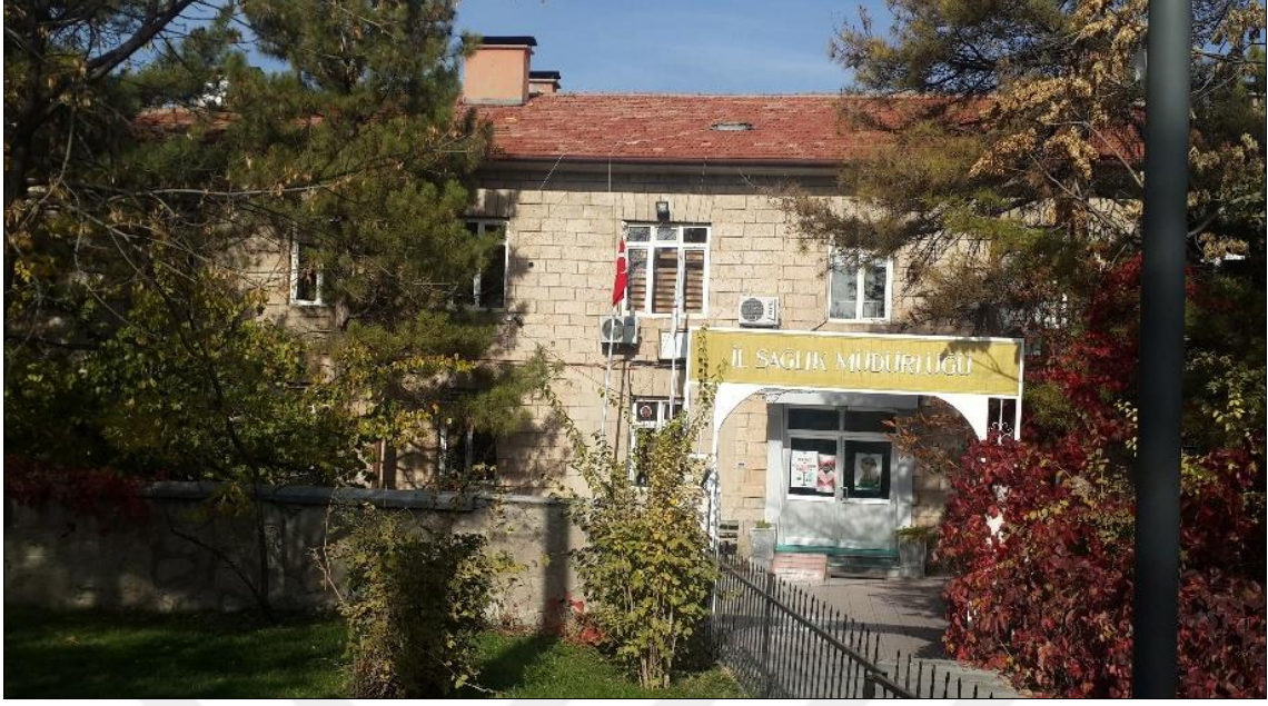
Resim 6.18. Yapının mevcut durumu 2017 – Elif Tektaş
