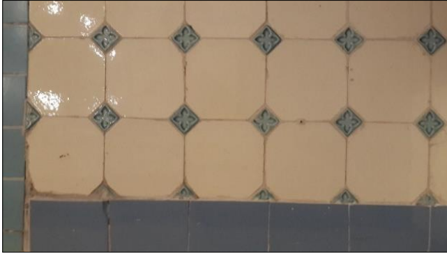
Resim 7.50. Kütüphane duvar kaplama 2017
