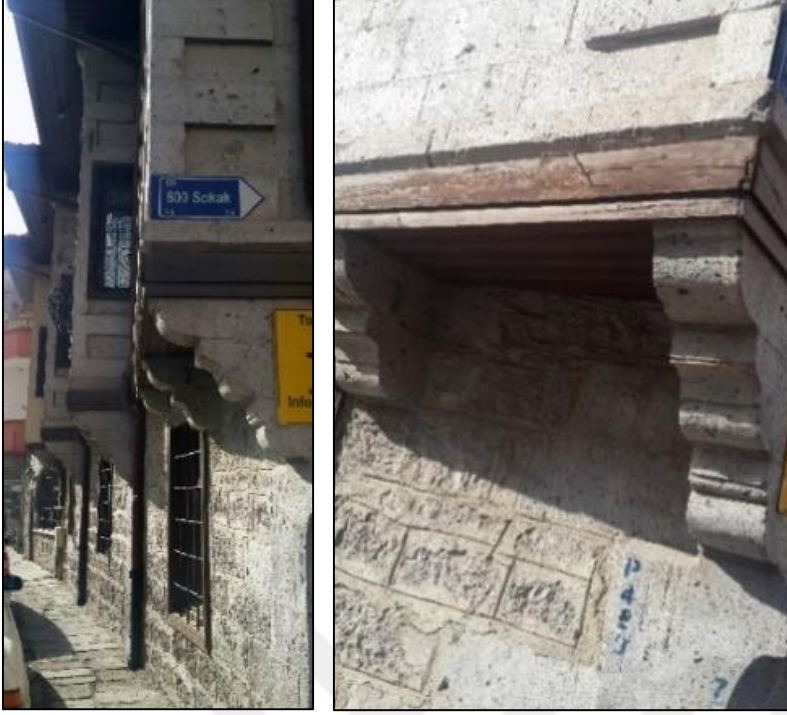
Resim 7.20. Yollar İdaresi Binası ahşap kat silmesi,taş konsol (furuş)
