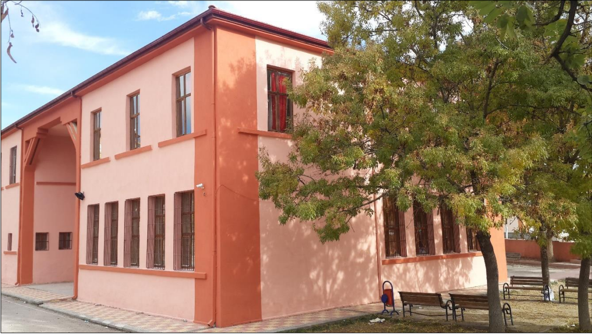
Resim 6.88. Gazi İlkokulu yan cephesi 2017
