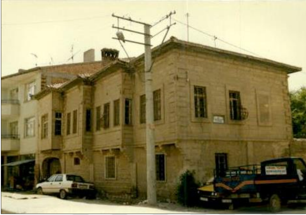
Resim 6.11. Yollar İdaresi Binası ön cephe [132]
