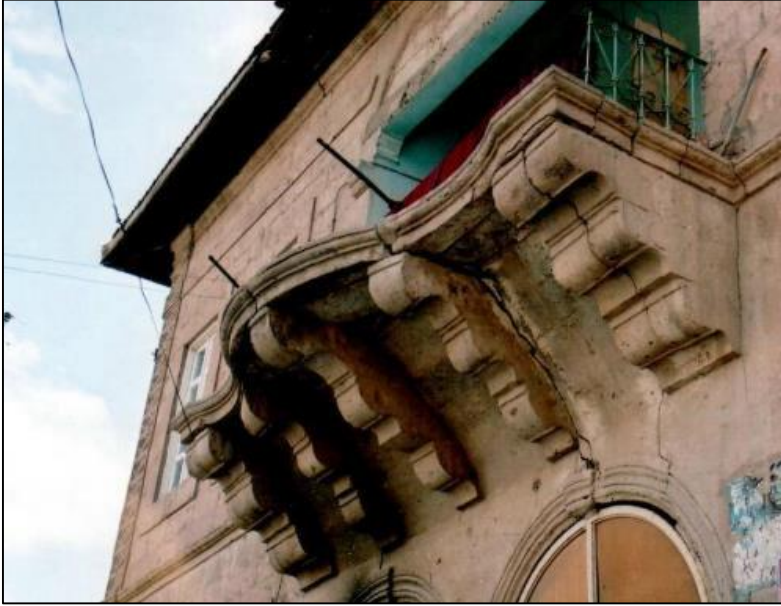
Resim 7.21. İbrahim Kaya Konağı (Mimarlar Odası Binası) taş konsollar, taş kat silmesi
