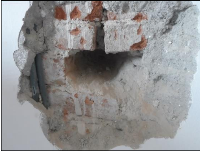
Resim 7.46. Adliye ve Jandarma Binası zmin katı dış duvarında yapılan raspa sonucu ortaya çıkan harman tuğla
