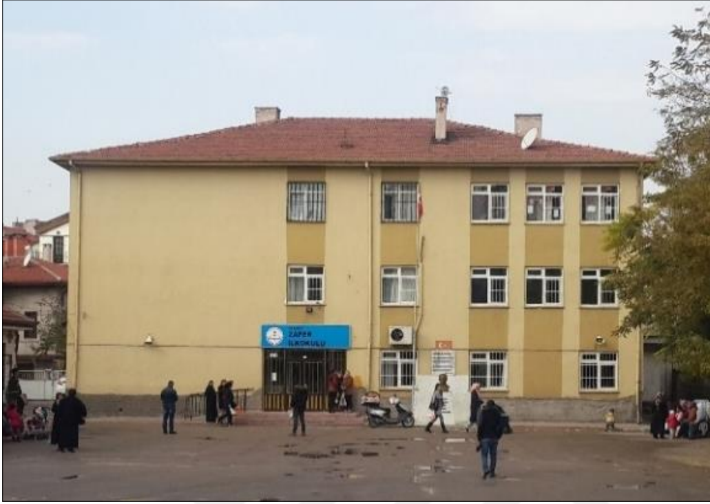
Resim 6.26. Zafer İlkokulu yeniden yapılan bina 2017
