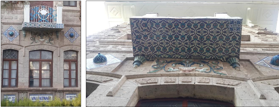
Resim 7.38. Vali Konağında cephe ve balkondaki çini uygulamaları 2017
