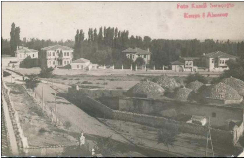
Resim 7.4. Aksaray Vali Konağı, Hamam, Vehhibey Caddesi [122]
