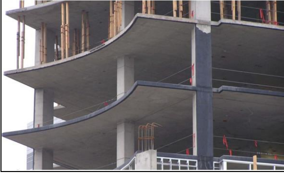
Resim 3.5. Yapım aşamasında olan kirişsiz döşeme sistemli bina (Deaton, 2005)
