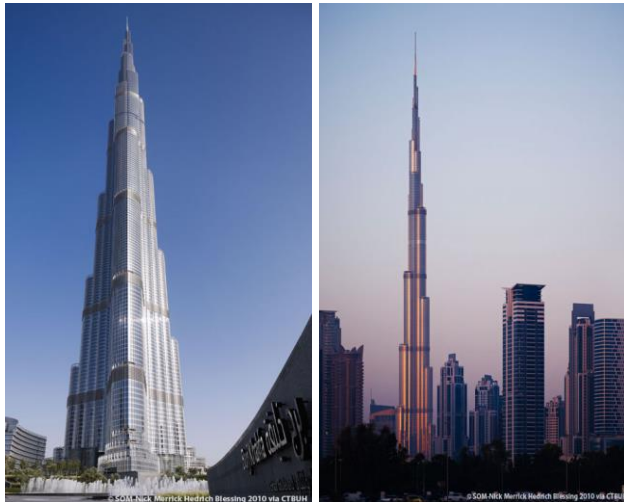
Resim 3.10. Burj Khalifa Binası (URL-16)
