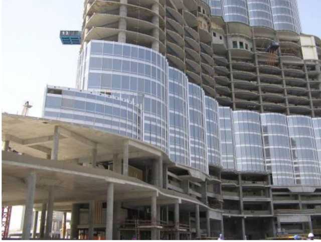
Resim 5.7. Binanın yapım aşamasından görünüm (Baker, Korista ve Novak, 2008)
