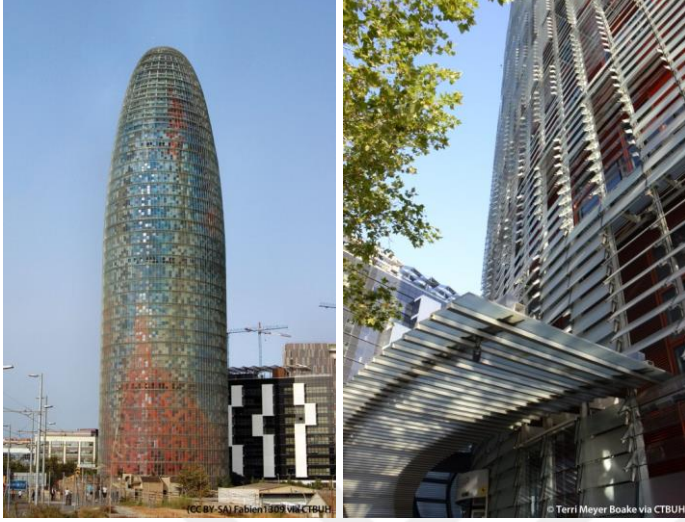
Resim 3.12. Torre Agbar Binası (çerçeve-tüp sistem bina örneği) (URL-25)
