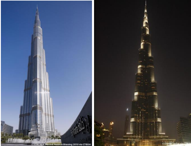
Resim 3.1. Burj Khalifa Binası (URL-16)
