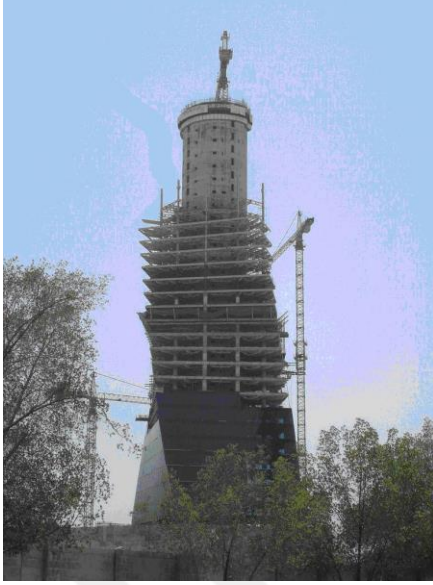
Resim 3.6. Betonarme çekirdekli yapı (URL-20)
