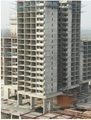
Resim 3.7. Betonarme perde duvarlı yapı (URL-21)
